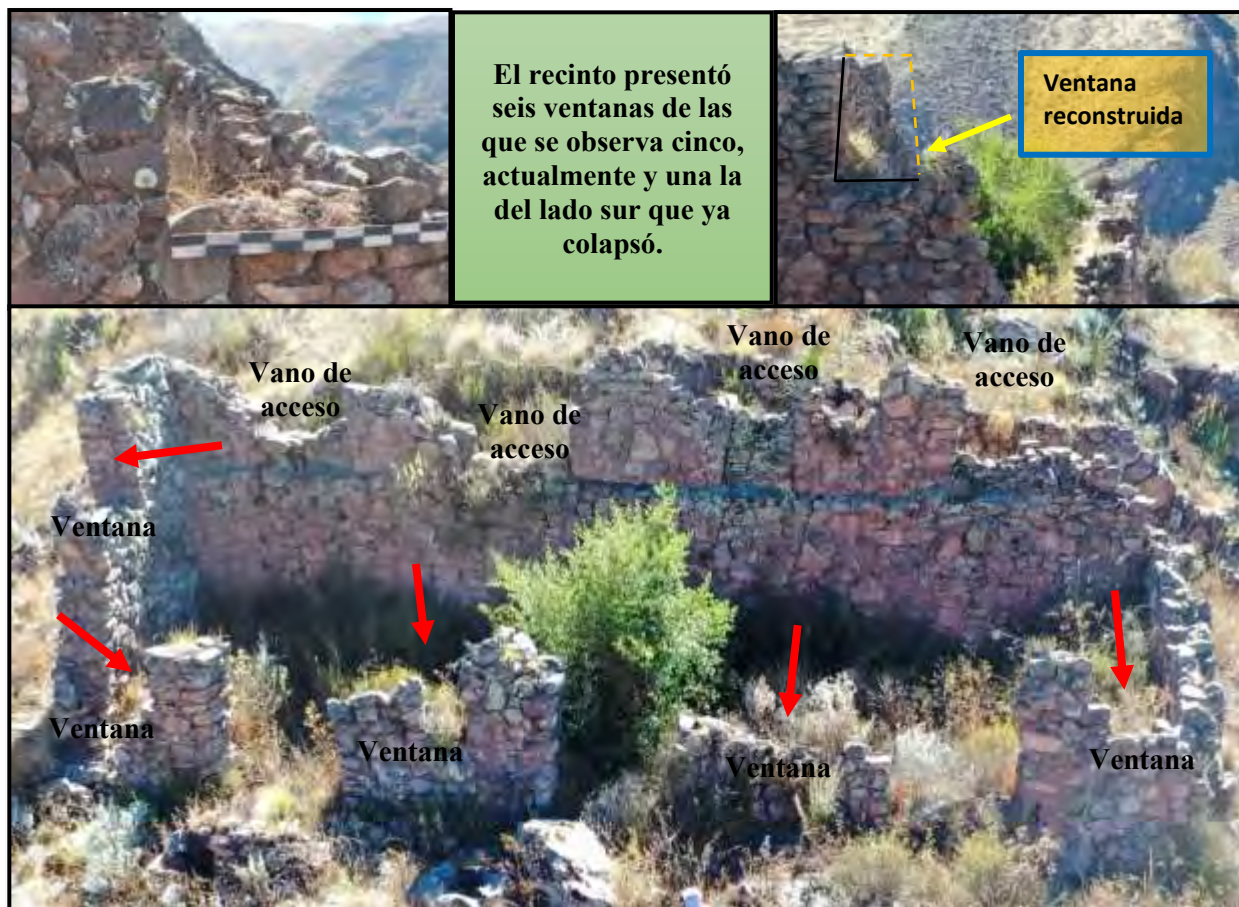
Vista de las ventanas del recinto R-1
