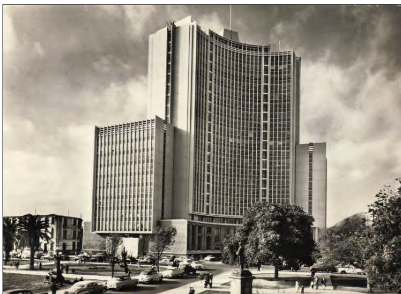
Figura 2-1. Edificio Javier Alzamora Valdez Fuente: Fabio Rodríguez (2015).
