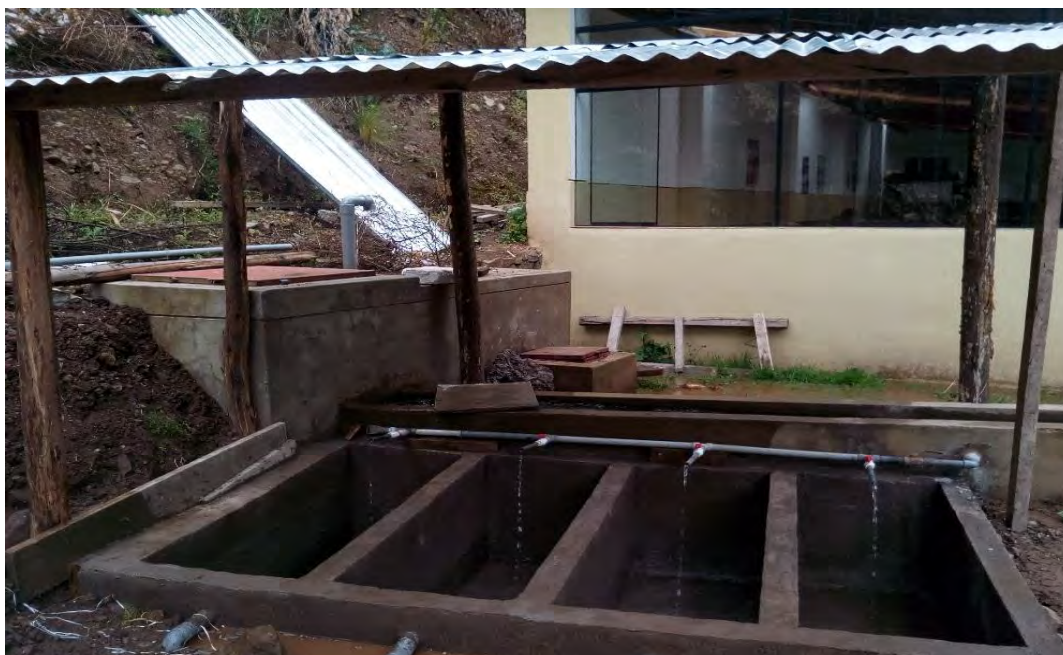
Figura 19. Fotografía de la adecuación e instalación de estanques.
