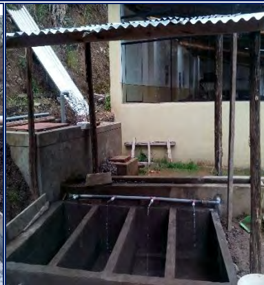
Adecuación de los estanques con protección de techo
