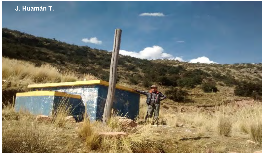
Figura 8. Reservorio de agua de sector Pilcocota que abastece a la población circundante del Bosque.
