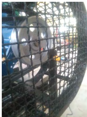
Figura 83. Instalación del sensor de presencia en la bomba turbina. Fuente: elaboración propia.
