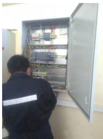
Figura 89. Trabajos de Conexión de tableros. Fuente: Elaboración propia.
