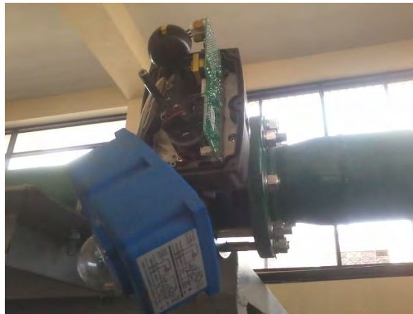
Figura 93. Conexión de electroválvula. Fuente: Elaboración propia.
