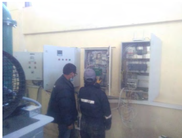
Figura 88. Inspección de funcionamiento de tableros. Fuente: Elaboración propia.
