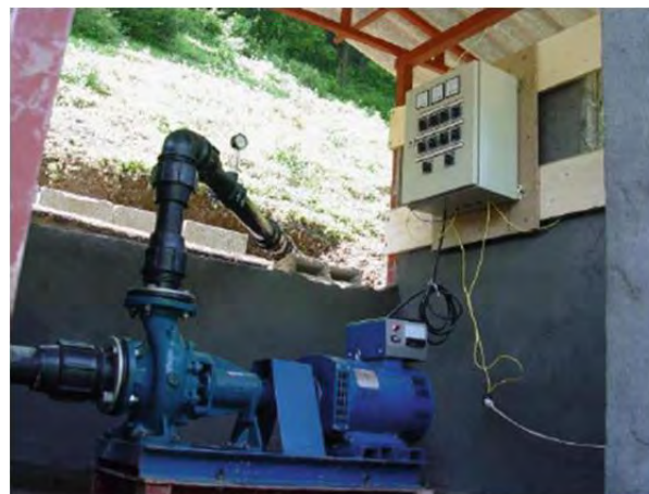
Figura 24. Bomba funcionando como turbina instalada en el oeste de Irán. Fuente: Carravetta et al. (2018).
