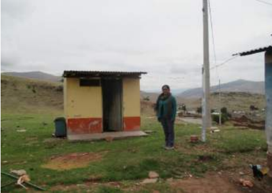
Proyecto: Mejoramiento y ampliación de los sistemas de agua potable, alcantarillado y tratamiento de aguas residuales en la comunidad de Congota
