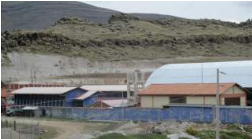
Imagen 3 Mejoramiento de la infraestructura del Instituto Superior Tecnológico Público de Challhuahuacho
