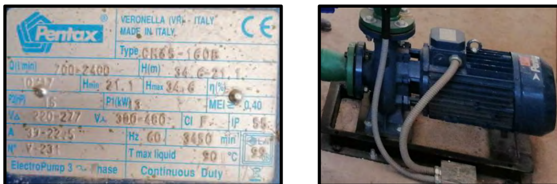
Figura 44: Datos de la placa de la BM e imagen. Fuente: Elaboración propia.
