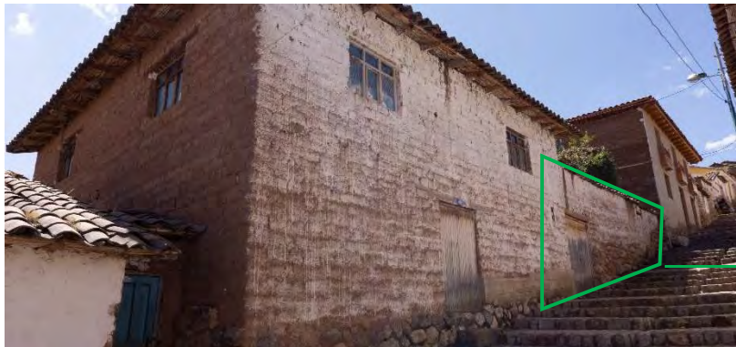
Figura 426: Fachada principal del Lote B2-21 hacia la Ca. Bolívar. (2021). Archivo propio.
