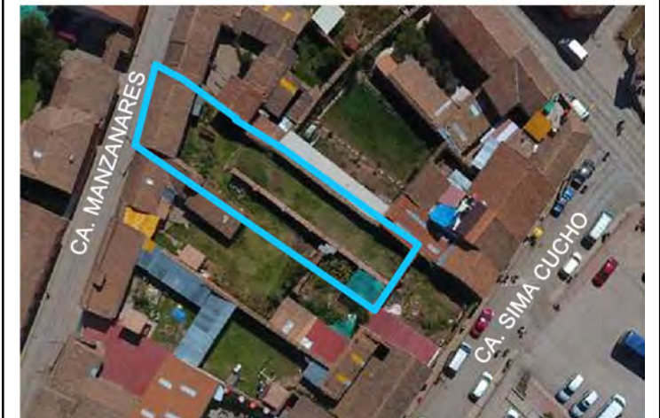
Figura 542: Vista aérea del Lote T2-24. (2019). Archivo propio.
