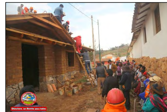
Figura 580: Faena para el techado de la casa varayoc de la comunidad de Yanacona. (2019). Municipalidad de Chinchero.
