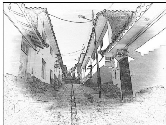
Figura 274: Ca. Bolívar como espacio en movimiento indicando continuidad, vista hacia el Este. (2021). Elaboración propia.
