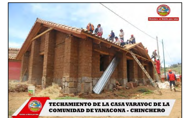
Figura 581: Faena para el techado de la casa varayoc de la comunidad de Yanacona. (2019). Municipalidad de Chinchero.
