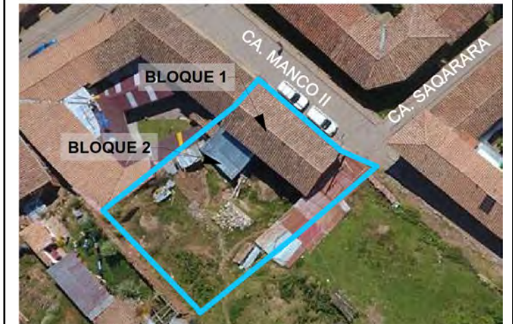
Figura 530: Vista aérea del Lote P3-02. (2019). Archivo propio.
