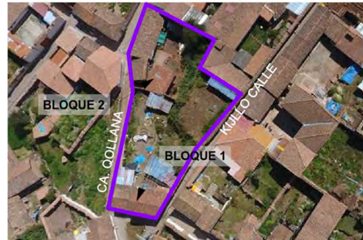
Figura 496: Vista aérea del Lote I2-04. (2019). Archivo propio.
