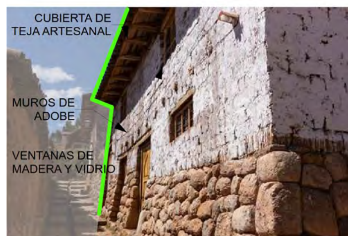
Figura 465: Fachada principal del Lote C2-01 hacia la Calle 19. (2021). Archivo propio.
