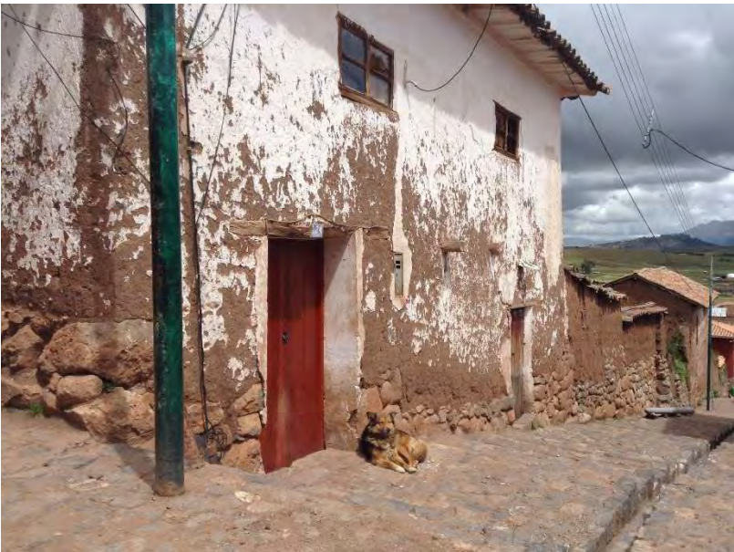
Figura 432: Fachada del Lote J2-03 hacia la Ca. Bolívar. (2017). Archivo propio.
