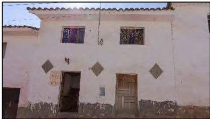
Figura 212: Horno en la calle Manzanares. (2021). Archivo Propio.
