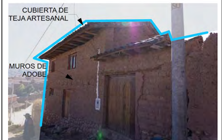
Figura 450: Fachada principal del Lote M3-07 hacia la Ca. Sinchi Roca. (2021). Archivo propio.
