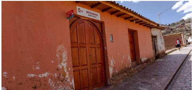
Figura 413: Fachada del lote W2-11 hacia la Ca. Manco II. (2021). Archivo propio.
