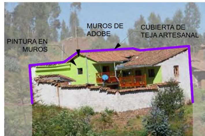
Figura 507: Interior del Lote I3-09. (2021). Archivo propio.
