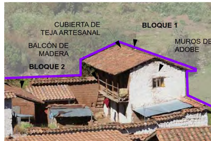
Figura 477: Interior del Lote L3-02. (2021). Archivo propio.
