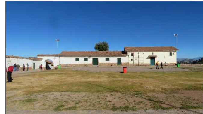
Figura 133: Vista hacia el Oeste desde la Plaza mayor. (2019). Archivo propio.
