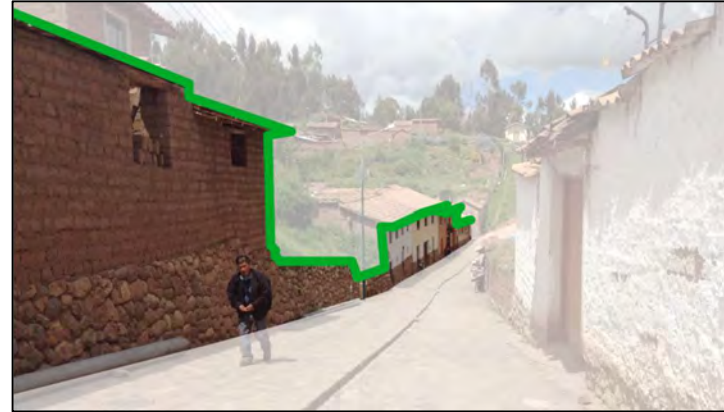
Figura 318: Vacío en el perfil en calle Pumacahua. (2020). Archivo propio.
