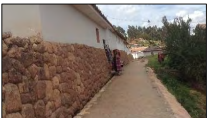
Figura 170: Calle Saqarara - afirmado. (2019). Archivo Propio.
