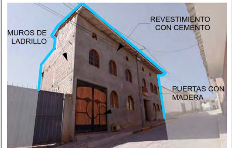
Figura 543: Fachada principal del Lote T2-24 hacia la Ca. Manzanares. (2021). Archivo propio.
