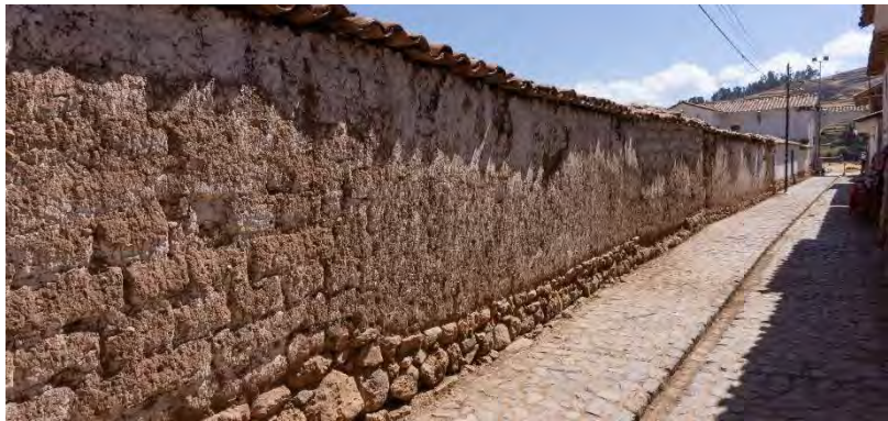
Figura 428: Fachada del Lote B2-21 hacia la Ca. Qollana. (2021). Archivo propio.
