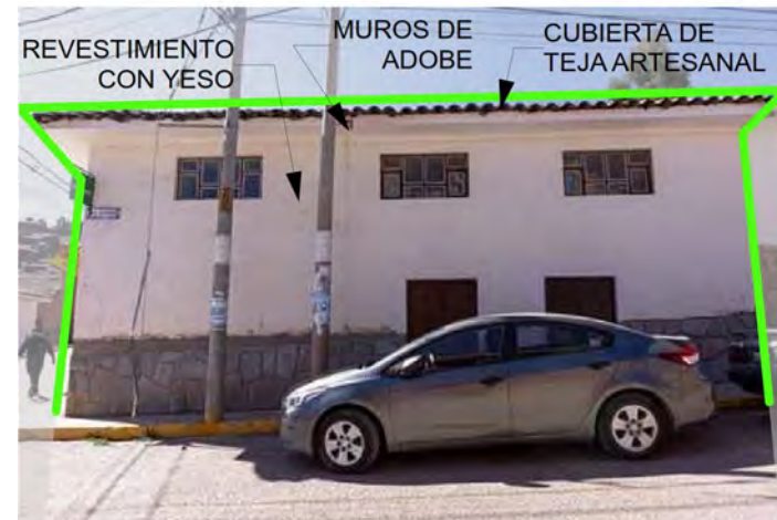
Figura 509: Fachada principal del Lote P3-01 hacia la Av. Garcilaso. (2021). Archivo propio.
