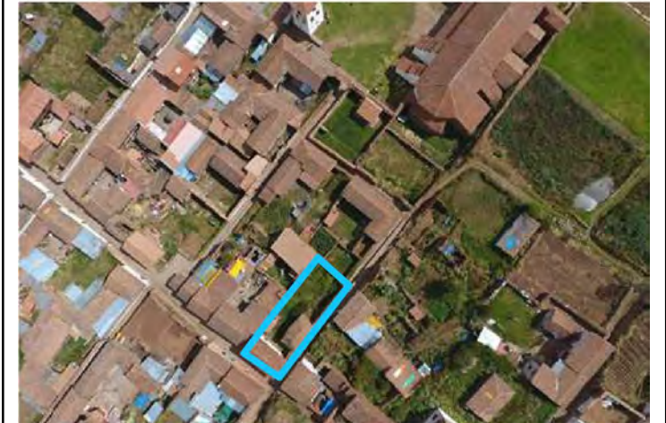
Figura 466: Vista aérea del Lote C2-03. (2019). Archivo propio.
