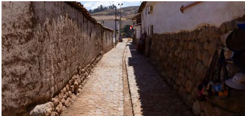
Figura 431: Fachada del Lote B2-22 hacia la Ca. Qollana. (2021). Archivo propio.
