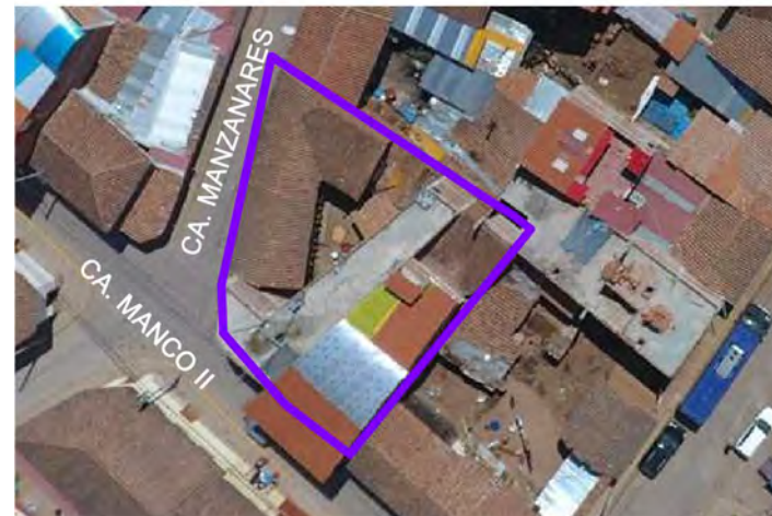
Figura 538: Vista aérea del Lote T2-18. (2019). Archivo propio.
