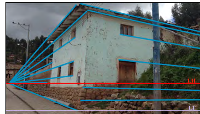
Figura 337: Percepción oblicua del inmueble desde la calle Chuspichaca. (2019). Archivo Propio.
