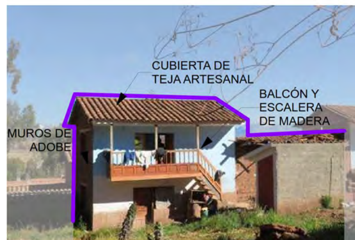
Figura 457: Fachada interior del Lote K3-07. (2021). Archivo propio.
