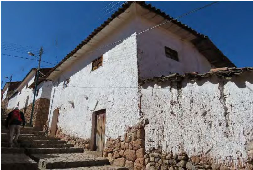
Figura 433: Fachada del Lote J2-03 hacia la Ca. Bolívar. (2021). Archivo propio.
