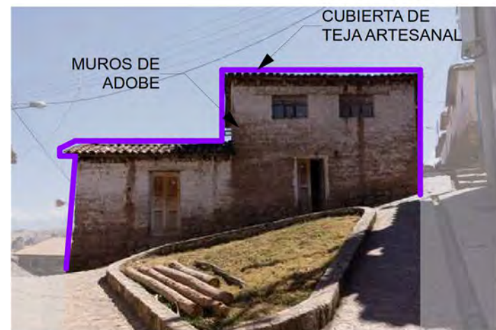
Figura 497: Fachada principal del Lote I2-04 hacia la Ca. Soctacucho. (2021). Archivo propio.
