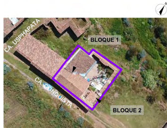
Figura 506: Vista aérea del Lote I3-09. (2019). Archivo propio.
