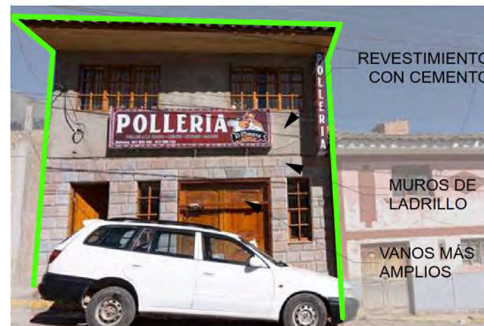
Figura 541: Fachada principal del Lote T2-15 hacia la Ca. Sima Cucho. (2021). Archivo propio.
