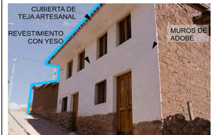
Figura 521: Fachada principal del Lote M3-04 hacia la Ca. Salaqata. (2021). Archivo propio.
