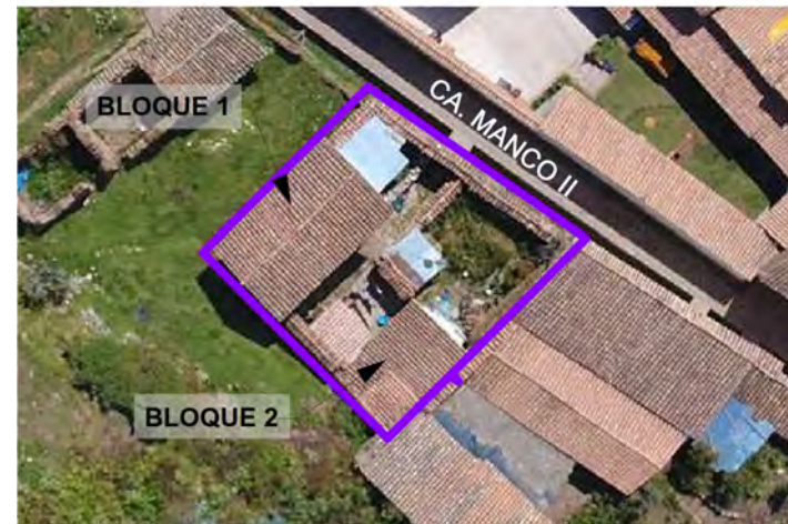
Figura 476: Vista aérea del Lote L3-02. (2019). Archivo propio.
