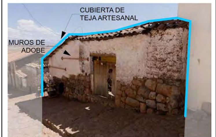
Figura 481: Fachada principal del Lote B2-10 hacia la Ca. Bolívar. (2021). Archivo propio.
