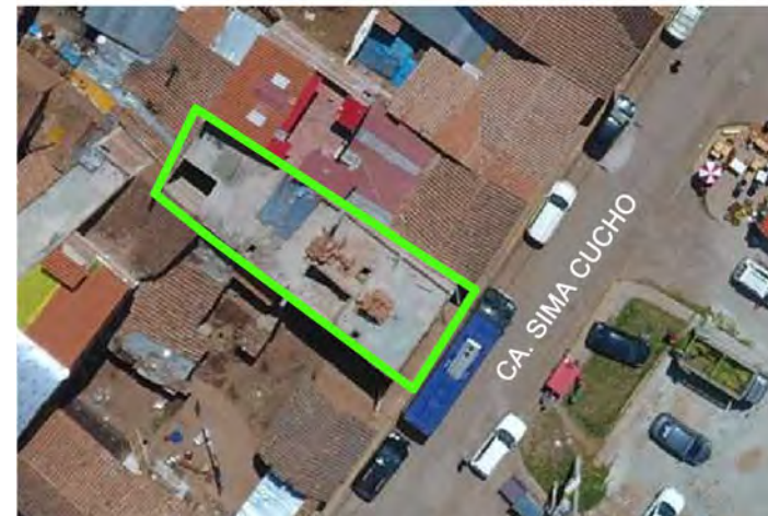
Figura 540: Vista aérea del Lote T2-15. (2019). Archivo propio.
