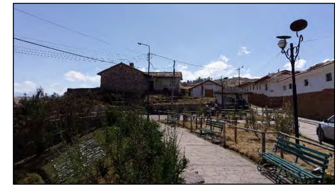
Figura 84: Plazoleta 4. (2021). Archivo propio.
