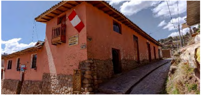
Figura 410: Fachadas del lote W2-11. (2021). Archivo propio.
