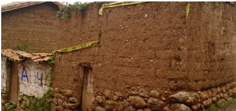
Figura 429: Fachada del Lote B2-22 hacia la Ca. Bolívar. (2017). Archivo propio.
