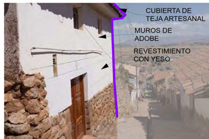
Figura 527: Interior del Lote I2-02 hacia la Ca. Bolívar. (2021). Archivo propio.
