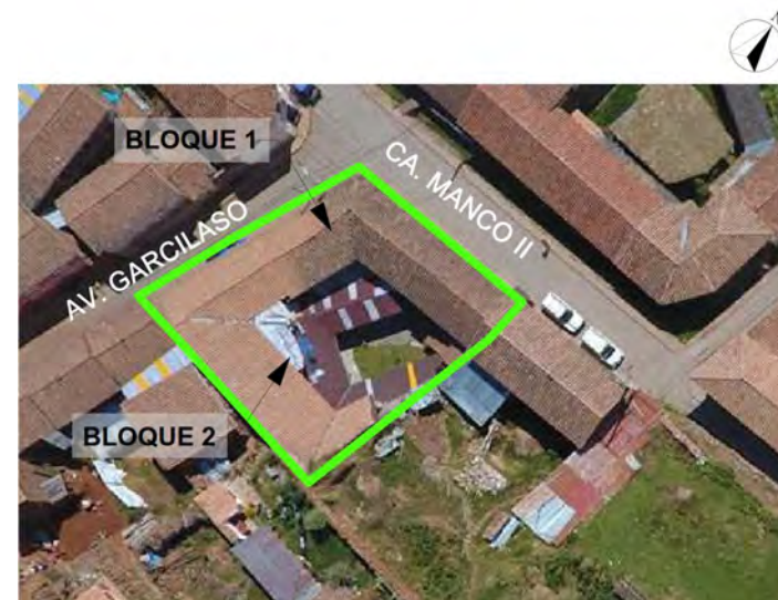
Figura 508: Vista aérea del Lote P3-01. (2019). Archivo propio.
