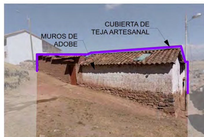
Figura 463: Fachada principal del Lote G2-03 hacia la Ca. Teqana Kantu. (2021). Archivo propio.
