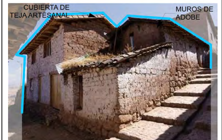
Figura 501: Vista del Lote Z2-07 esquina de la Ca. Manco II con la Ca. Pampawasi. (2021). Archivo propio.
