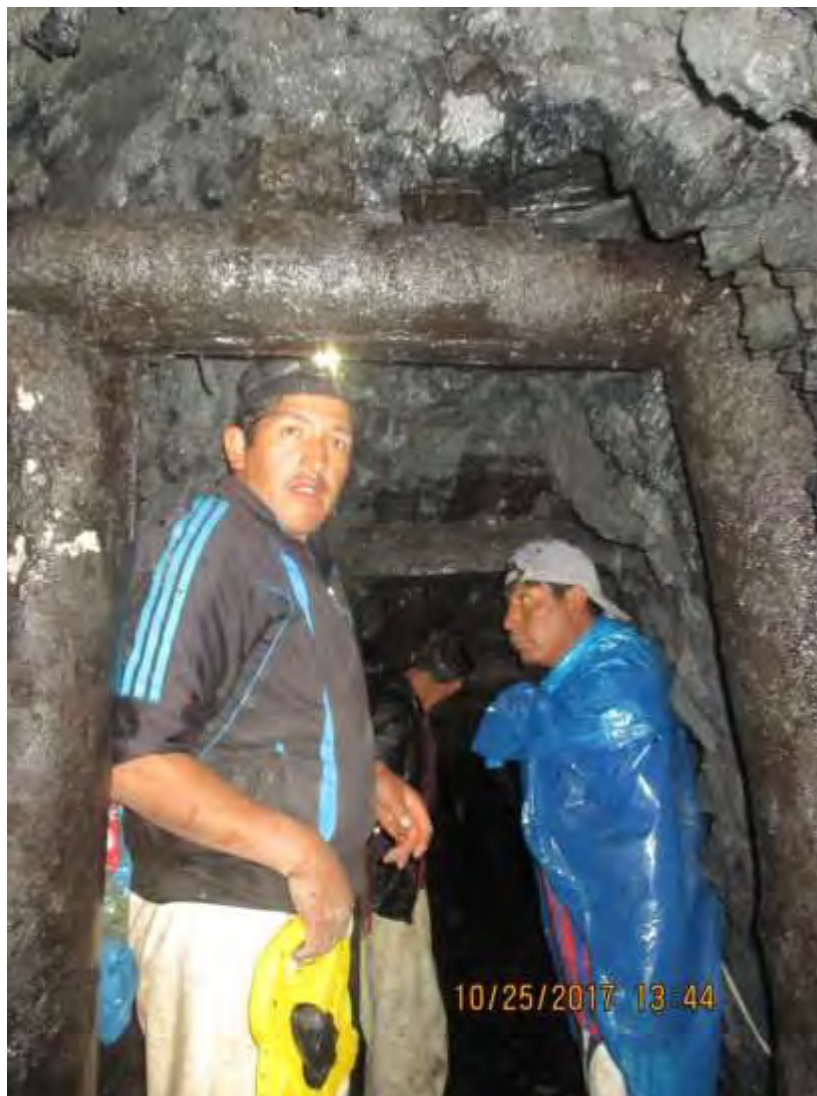
Figura 6. En el entibado de madera en tramos de 2 a 3 metros en roca limolitas pizarrosas muy húmedo se comporta muy debilitada como falla.
