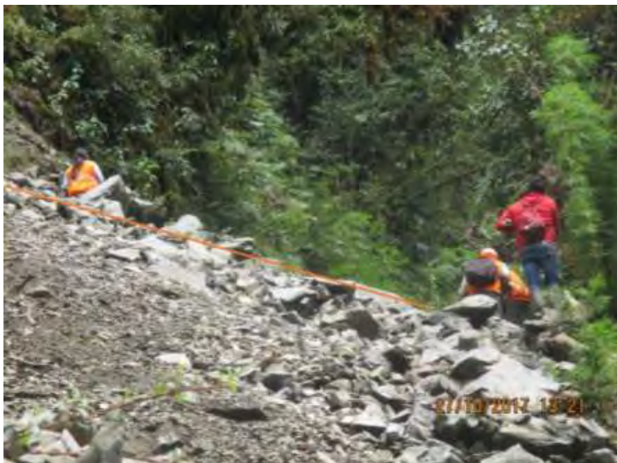
Figura 20. Inspección y apertura de camino para la línea D5.
