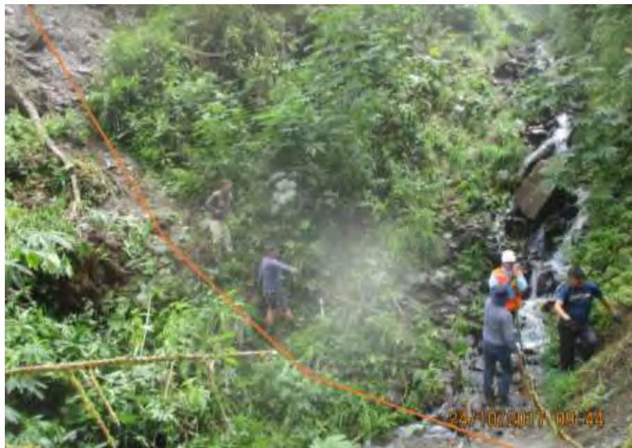
Figura 12. Inspección y apertura de camino para la línea L1.
