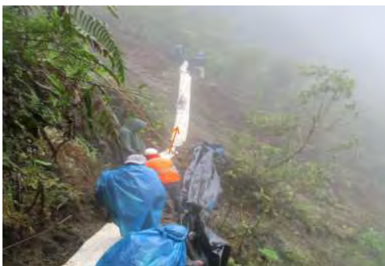
Figura 15. Inspección y apertura de camino para la línea L4.
