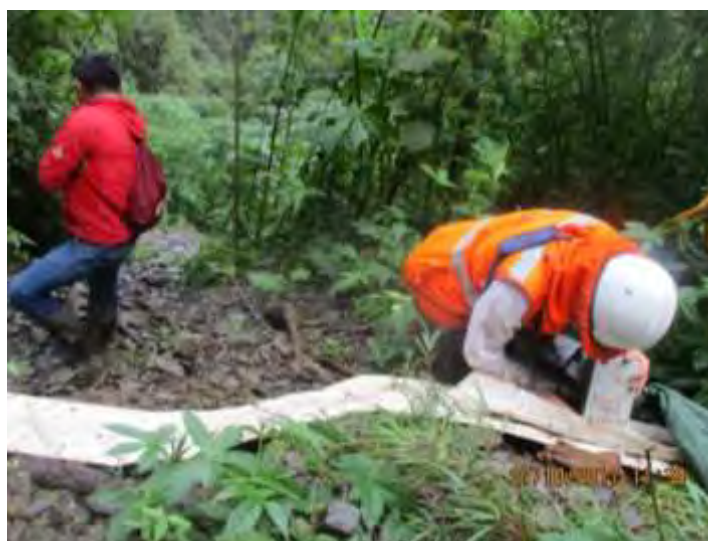
Figura 18. Inspección y apertura de camino para la línea D3.
