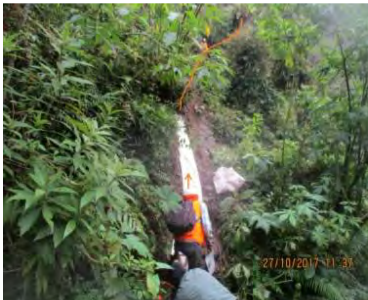
Figura 17. Inspección y apertura de camino para la línea D2.
