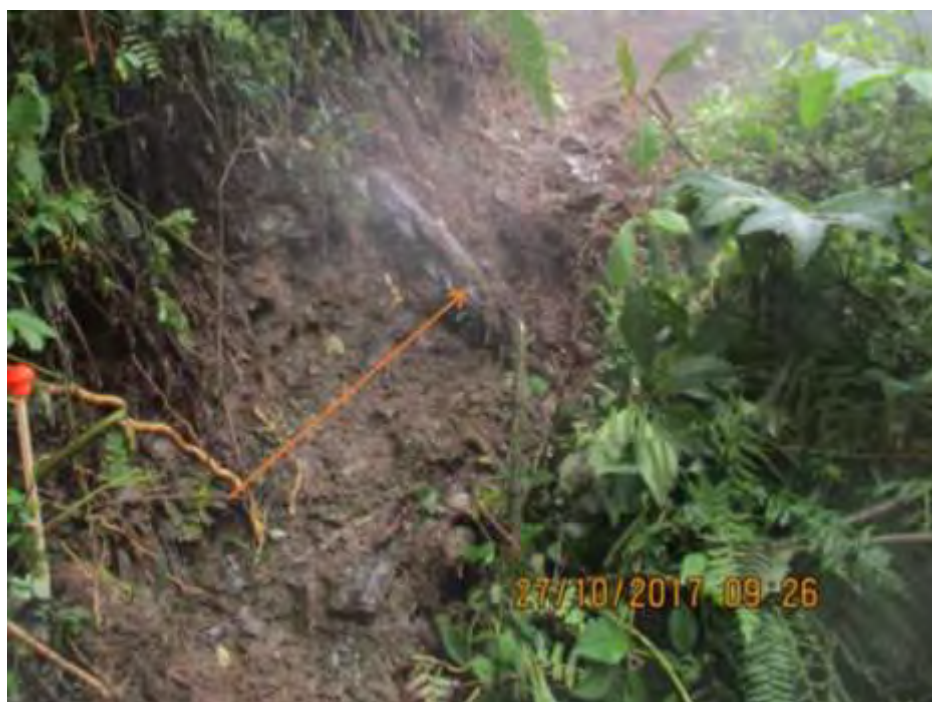
Figura 16. Inspección y apertura de camino para la línea D1..
