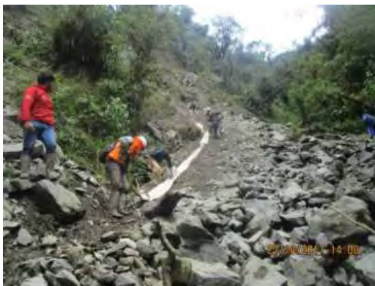
Figura 21. Inspección y apertura de camino para la línea D6.
