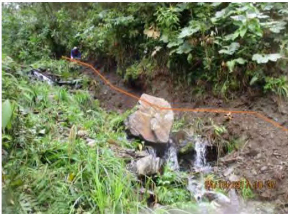
Figura 13. Inspección y apertura de camino para la línea L.2
