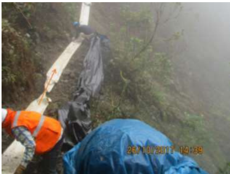
Figura 14. Inspección y apertura de camino para la línea L3.
