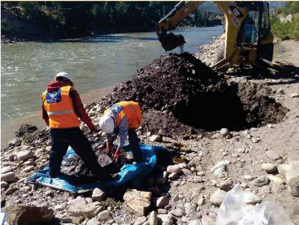
*Fotografía N°15: excavación de los pozos de exploración o calicata con retroexcavadora para su posterior análisis lito-estratigráfico y caracterización del tipo de suelo.*
