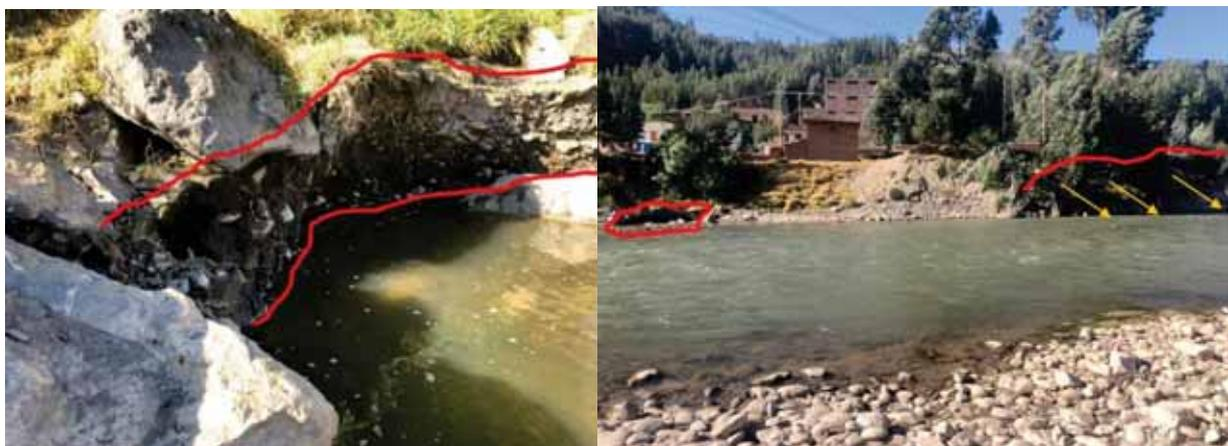
Fotografía N°4: Erosión en cárcavas encontrados a lo largo de la margen derecha del río Vilcanota, aguas arriba.
