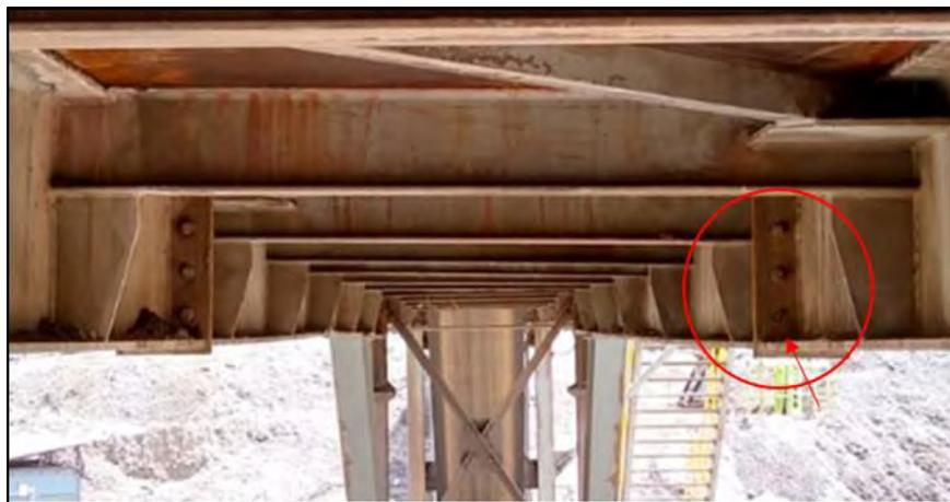
*Figura 111. Corrosión en la unión de la brida.*
