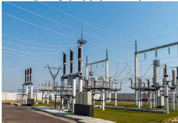
Figura 1 - Ejemplo equipos primarios o de patio
