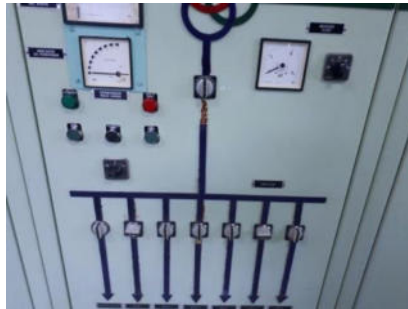
Figura 4 - Ejemplo tableros mímicos parte BT de una SET
