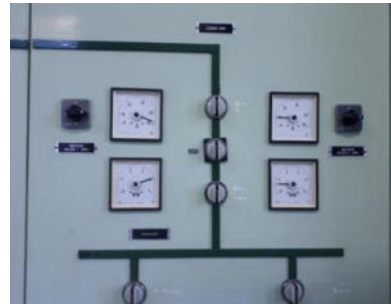
Figura 5 - Ejemplo tableros mímicos parte MT de una SET
