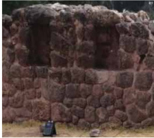
Figura 3.20: Muro de prueba 2
