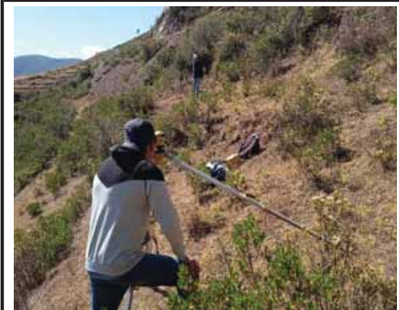
NIVELACION DE IDA 2+000 km A 2+500 km
