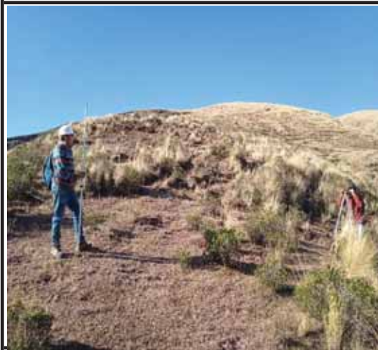
NIVELACION DE IDA 4+500 km A 5+000 km
