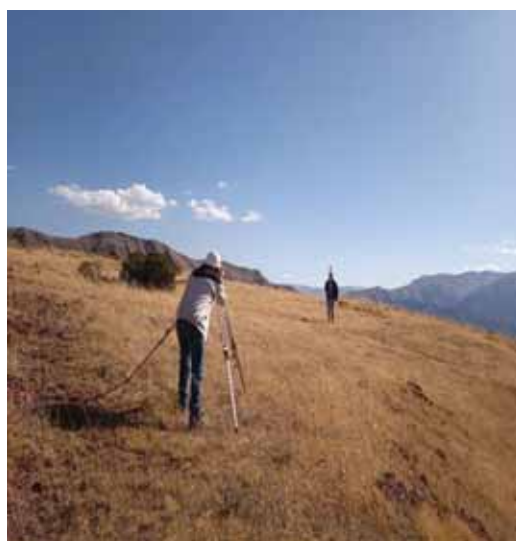
NIVELACION DE VUELTA 6+500 km A 6+884 km
