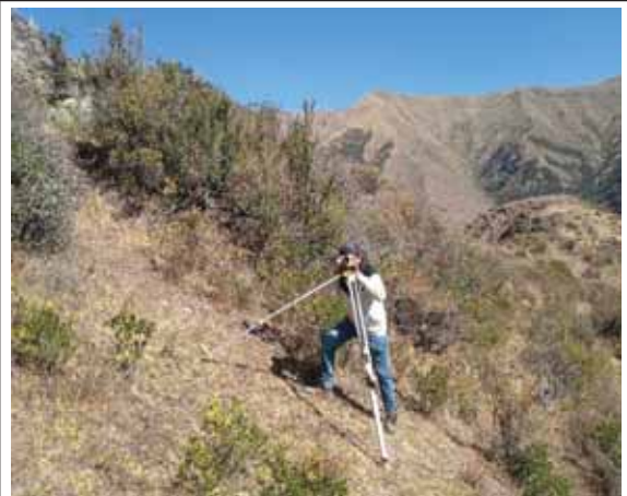
NIVELACION DE VUELTA 1+500 km A 2+000 km
