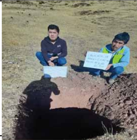
EXCAVACION DE CALICATAS
