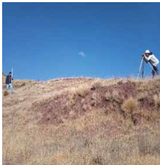
NIVELACION DE IDA 6+500 km A 6+000 km
