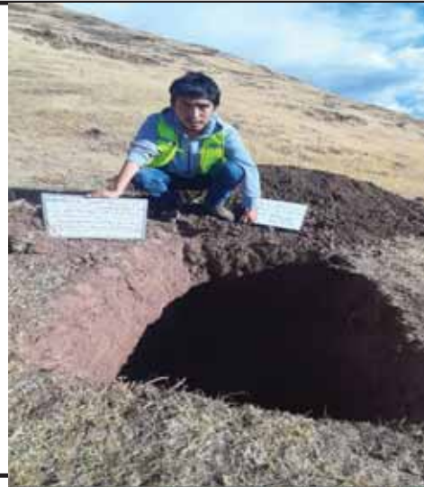
EXCAVACION DE CALICATAS
