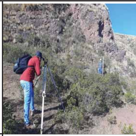
NIVELACION DE VUELTA 4+000 km A 2+500 km
