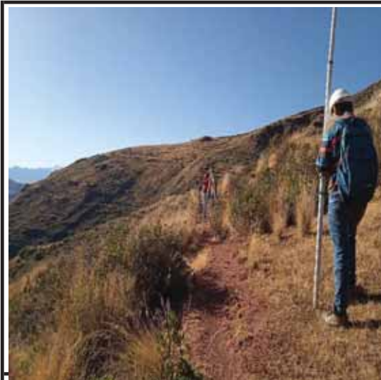
NIVELACION DE IDA 4+000 km A 2+500 km
