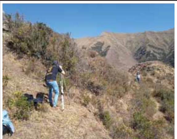
NIVELACION DE VUELTA 2+000 km A 2+500 km
