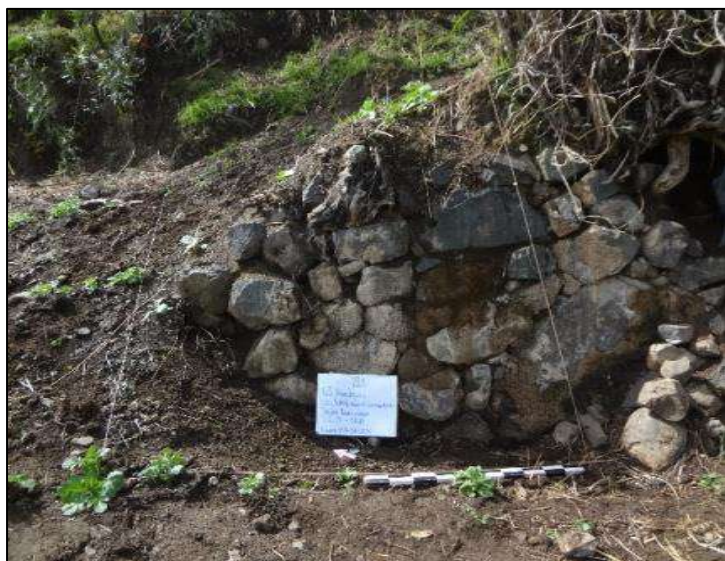
Fotografía 22. Vista de muro en el recinto 1. Obsérvese un muro construido con piedra caliza canteada y mortero de arcilla para la junta de los elementos líticos.
