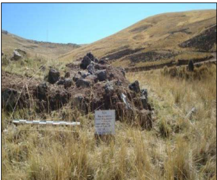
Fot. 19 Vista del Recinto 3 perteneciente al S.A. de Willkakunka. Se observan elementos líticos en proceso de colapso, además se puede apreciar parte del mortero de arcilla que se usó para unir estas piedras sin cantar.
