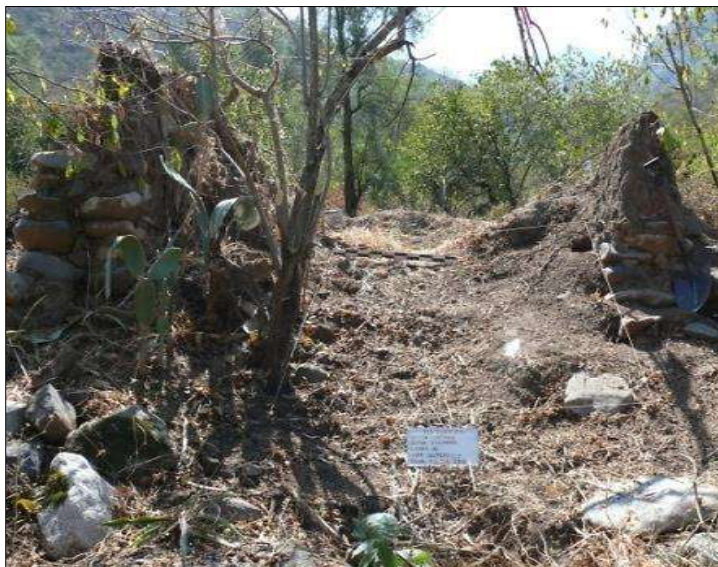
Fotografía 25. Vista de muro longitudinal y transversal, Sicsibamba. El muro que se observa en la imagen corresponde a una estructura de data colonial. El intemperismo y la vegetación fueron deteriorando los restos culturales en esta zona.
