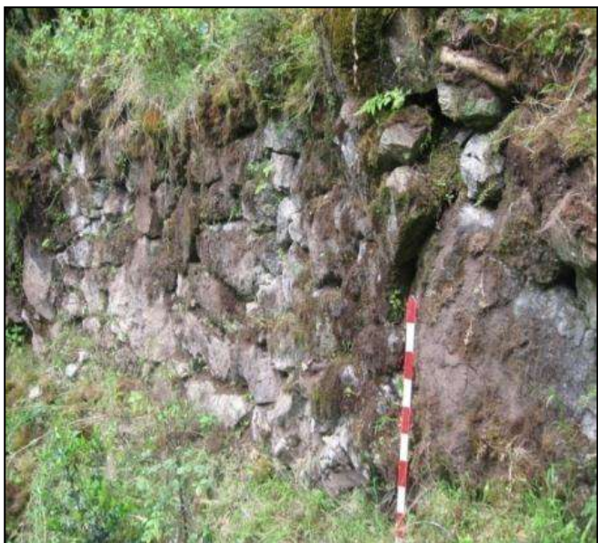
Fot. 09 Vista del muro del tercer andén del Sector B, perteneciente al S.A. de Paqaq'asa.
