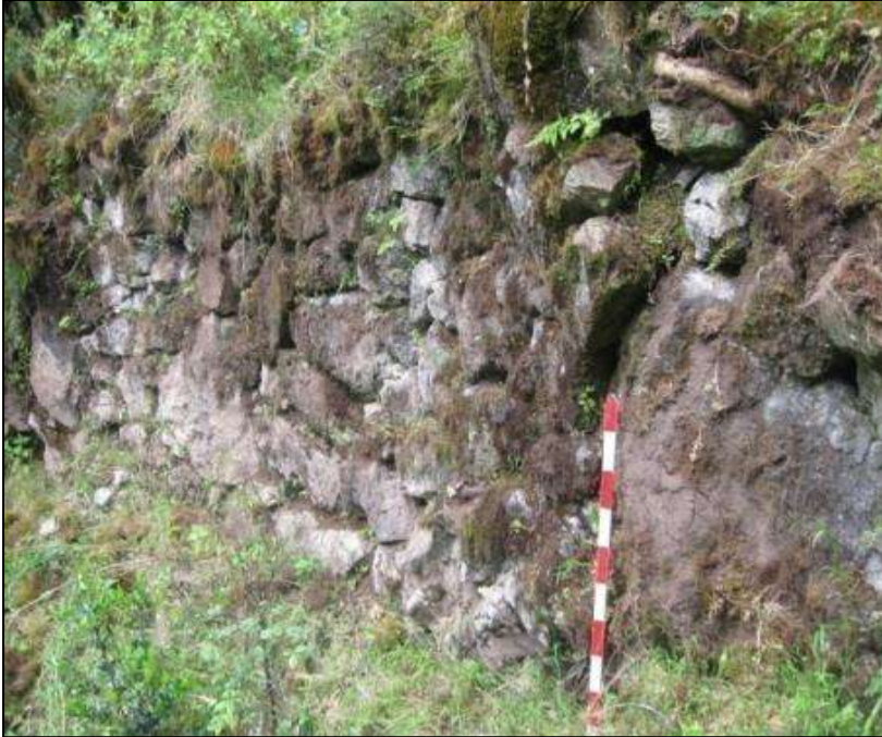
Fotografía 7. Vista del muro del tercer andén del Sector B, perteneciente al S.A. de Paqaq'asa.
