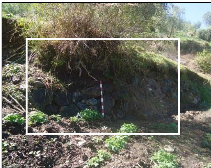
Fot. 33 Sitio de Arrayampata, en la sección de Loretuyoq a Huanca Huanca. En la imagen se visualiza una terraza constituida de piedras grandes de caliza, talladas en forma celular.
