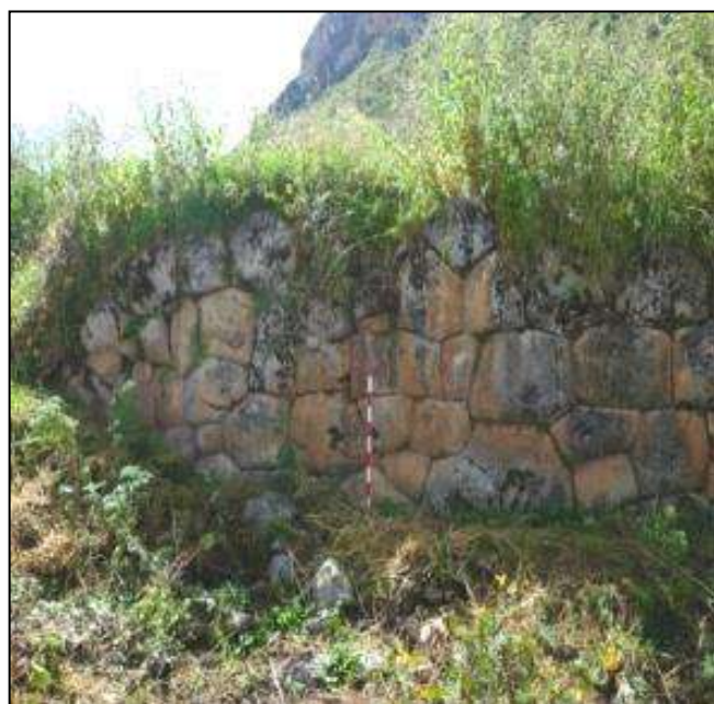
Fot. 29 Detalle de plataforma semicircular bordeado por un muro de mampostería celular almohadillado, el material constructivo utilizado fue la piedra caliza.
