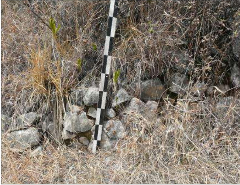
Fotografía 26. Vista de muro de mampostería simple en el Sitio Arqueológico de Sicsibamba; se observa el muro bastante deteriorado debido a la abundante vegetación y maleza que descompone el material lítico.
