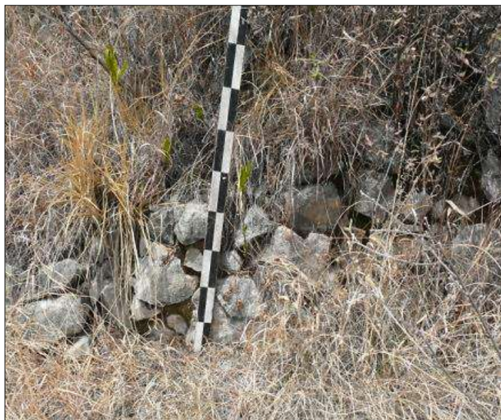
Fot. 36 Vista de muro de mampostería simple en el Sitio Arqueológico de Sicsibamba; se observa el muro bastante deteriorado debido a la abundante vegetación y maleza que descompone el material lítico.
