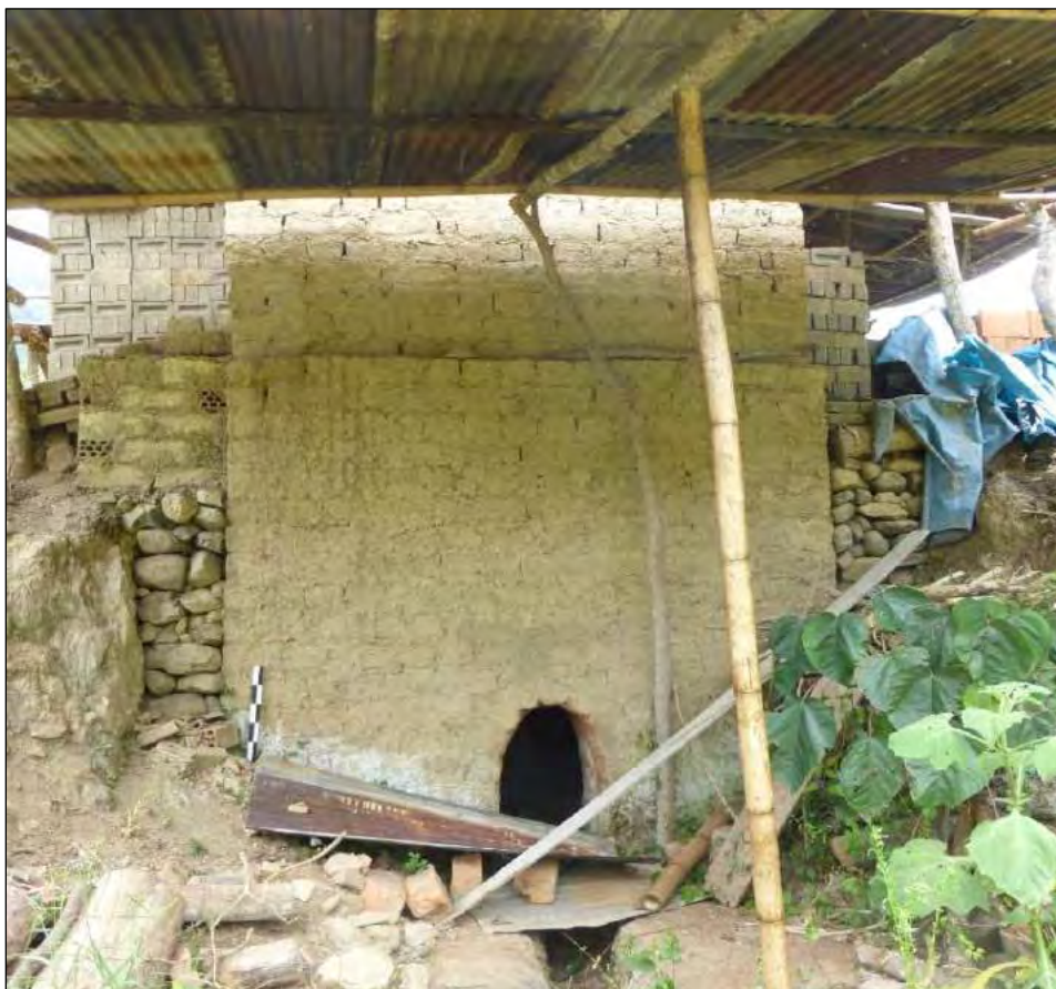
Figura 17: Vista del horno actual para la cocción del bloquer y ladrillo
