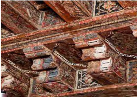
**Ménsulas:** Elemento saliente del plano del muro cuya función es sostener partes en voladizo.
