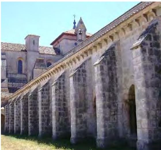
**Contrafuertes:** Pilar de la fábrica saliente en un paramento de un muro para fortalecerlo.
