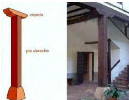
**Pie Derecho:** elemento vertical de madera que sirve de apoyo a una estructura de cubierta.
