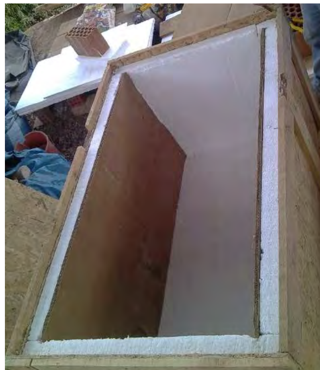
Instalación de primera capa de cartón (e=4mm)
