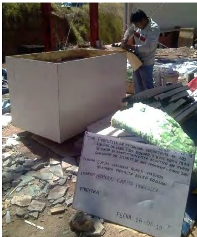
Vista exterior de cámara anecoica
