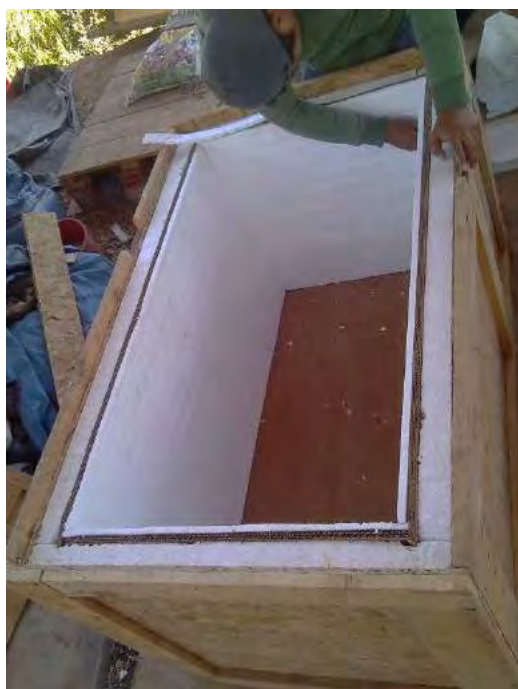
Instalación de segunda capa de tecnopor (e=1")
