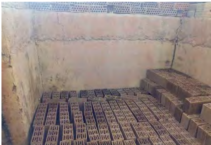
Llenado de horno para cocción de las nuevas unidades de albañilería
