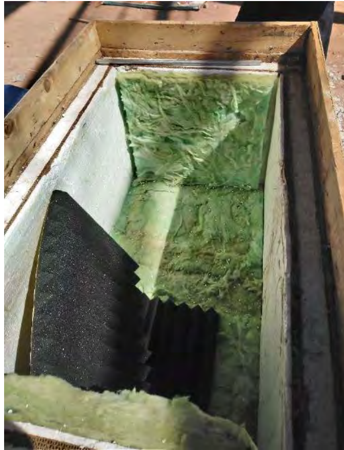
Forrado de cámara con espuma acústica tipo cuña
