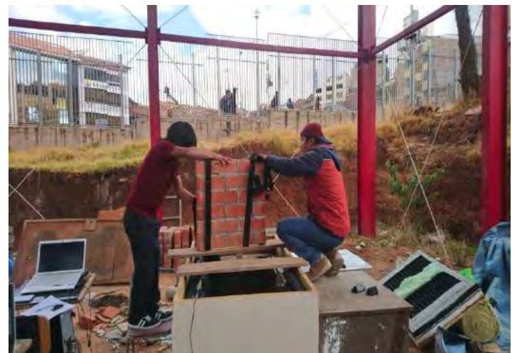
Cambio de muros de la cámara anecóica
