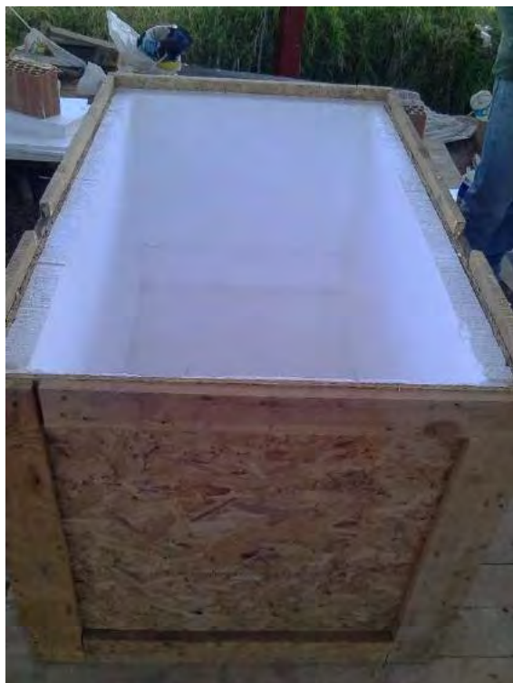
Instalación de primera capa de tecnopor (e=4")
