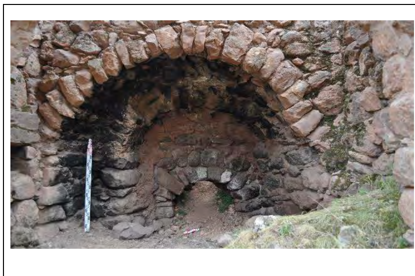
Figura 62. Acceso a la boca de descarga en el lado Sureste, horno N° 6 Fuente: Propia.
