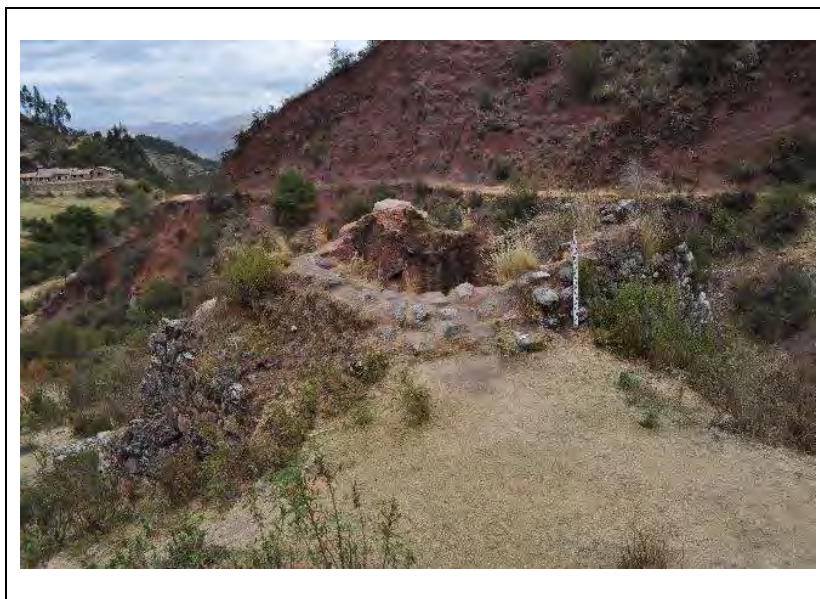
Figura 67. Terraplén de acceso a la boca de carga
