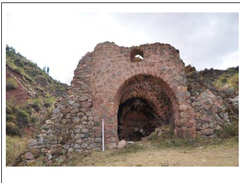
Figura 66. Contrafuertes adheridos al muro externo del horno N° 6
