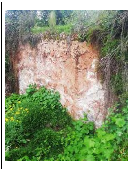
Figura 49. Restos de cal, en la cámara interna del Horno
