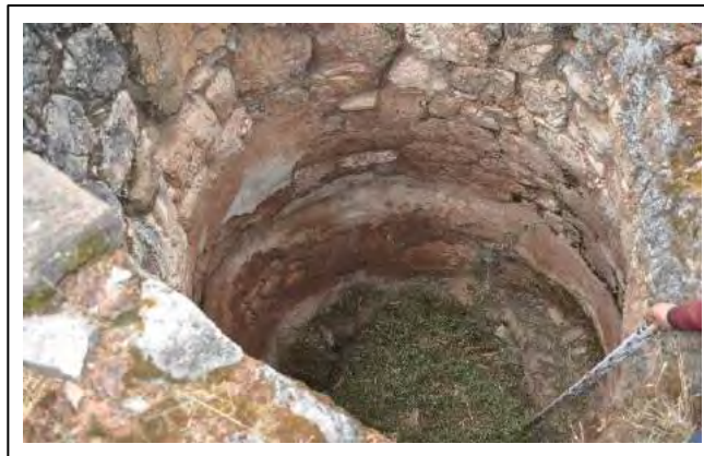
Figura 53. Cámara interna de horno N° 3, con restos de revoque.
