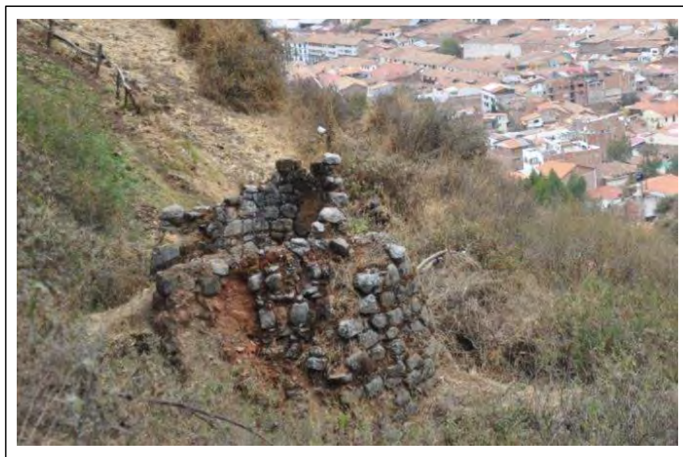
Figura 85. Muro de mampostería rustica, Horno N° 03
