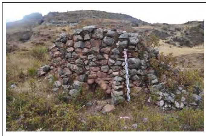
Figura 58. Boca de Descarga del lado Noreste, horno N° 5.
