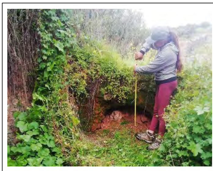
Figura 48. Boca de descarga Horno N° 2
