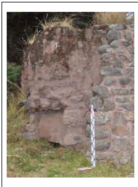
Figura 79. Boca de descarga del horno
