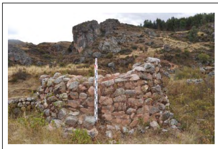
Figura 61. Contrafuertes o paravientos, adosados al muro exterior del horno N° 5
