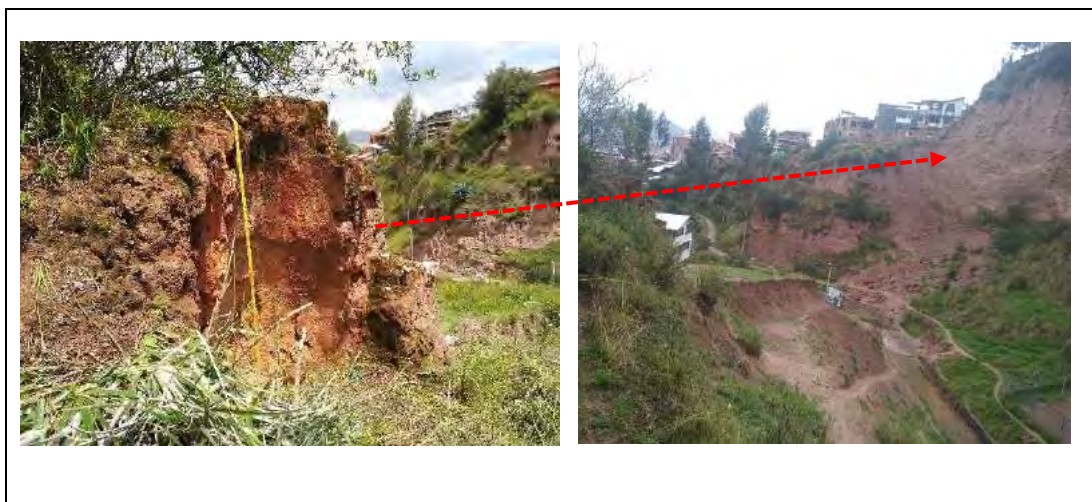
Figura 102. Yacimiento de tierra arcillosa de color rojizo en Salineras distíngase en el Horno N° 10
