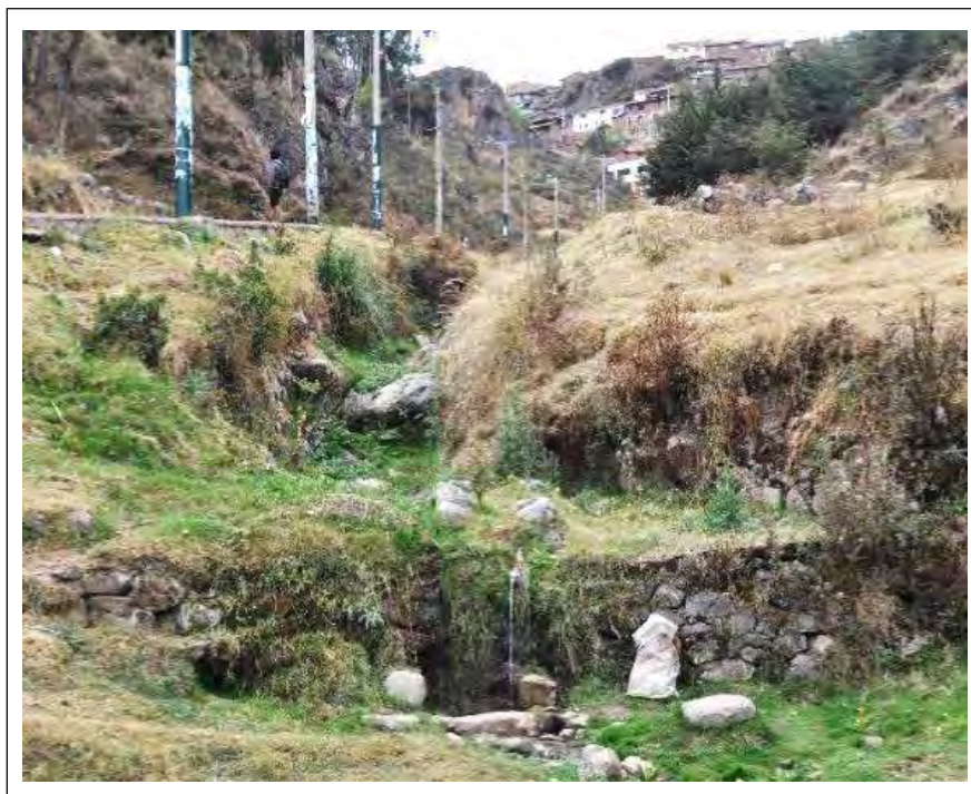
Figura 34. Conducto de Agua
