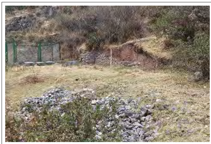
Figura 31. Muro de andén
