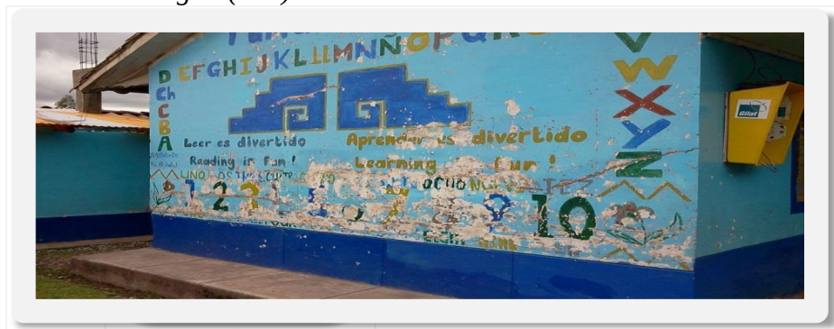
Figura 4 Infraestructura antigua (PIP)
