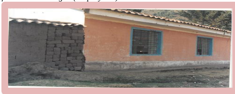
Figura 5 Infraestructura antigua (sin proyecto). Construcción de adobe
