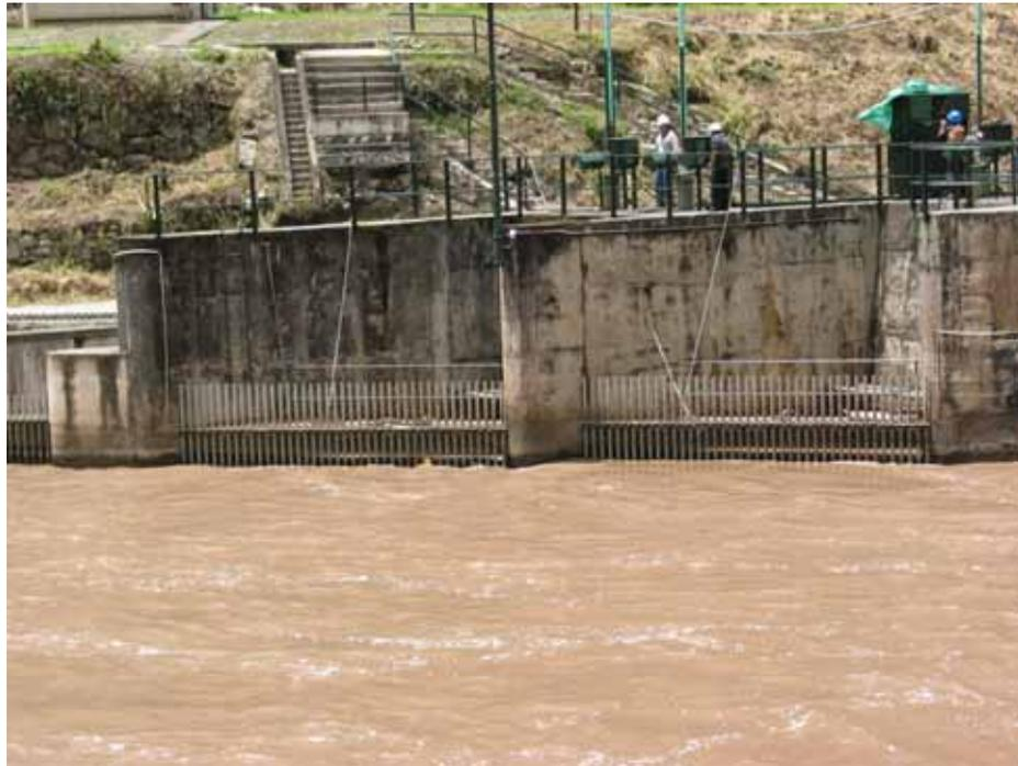
*Ilustración 5: Bocatoma con los sistemas de accionamiento de Compuertas de Toma*
