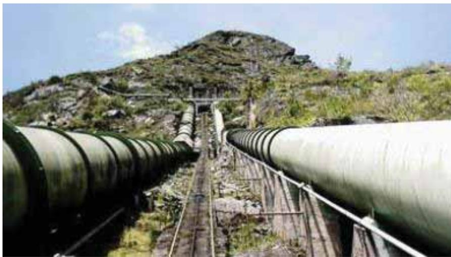
**Ilustración 13:** *Sistemas de Tuberías Forzadas y Salto Hidráulico*
