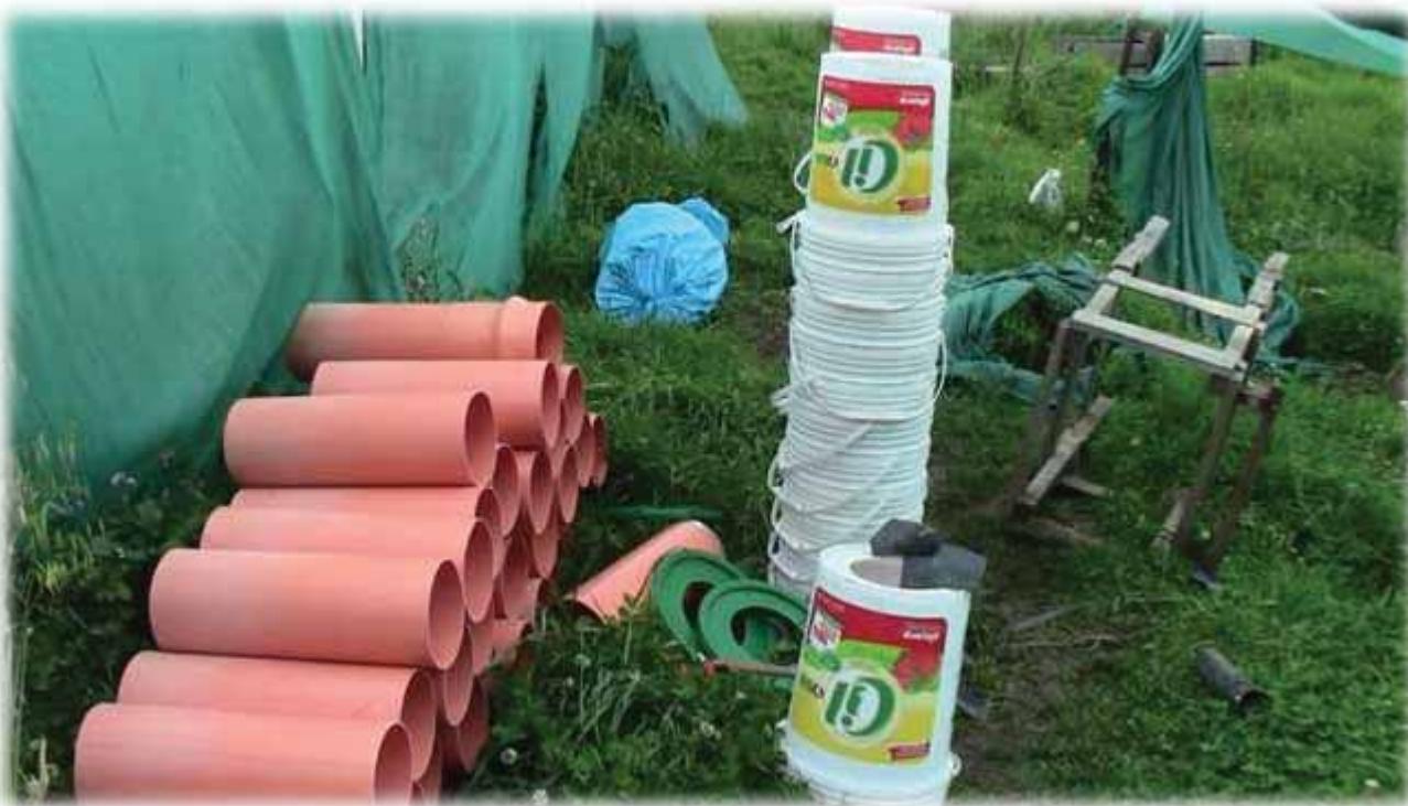
Fotografía N° 6: Recursos tubería de 6", balde de polietileno de 20 L
