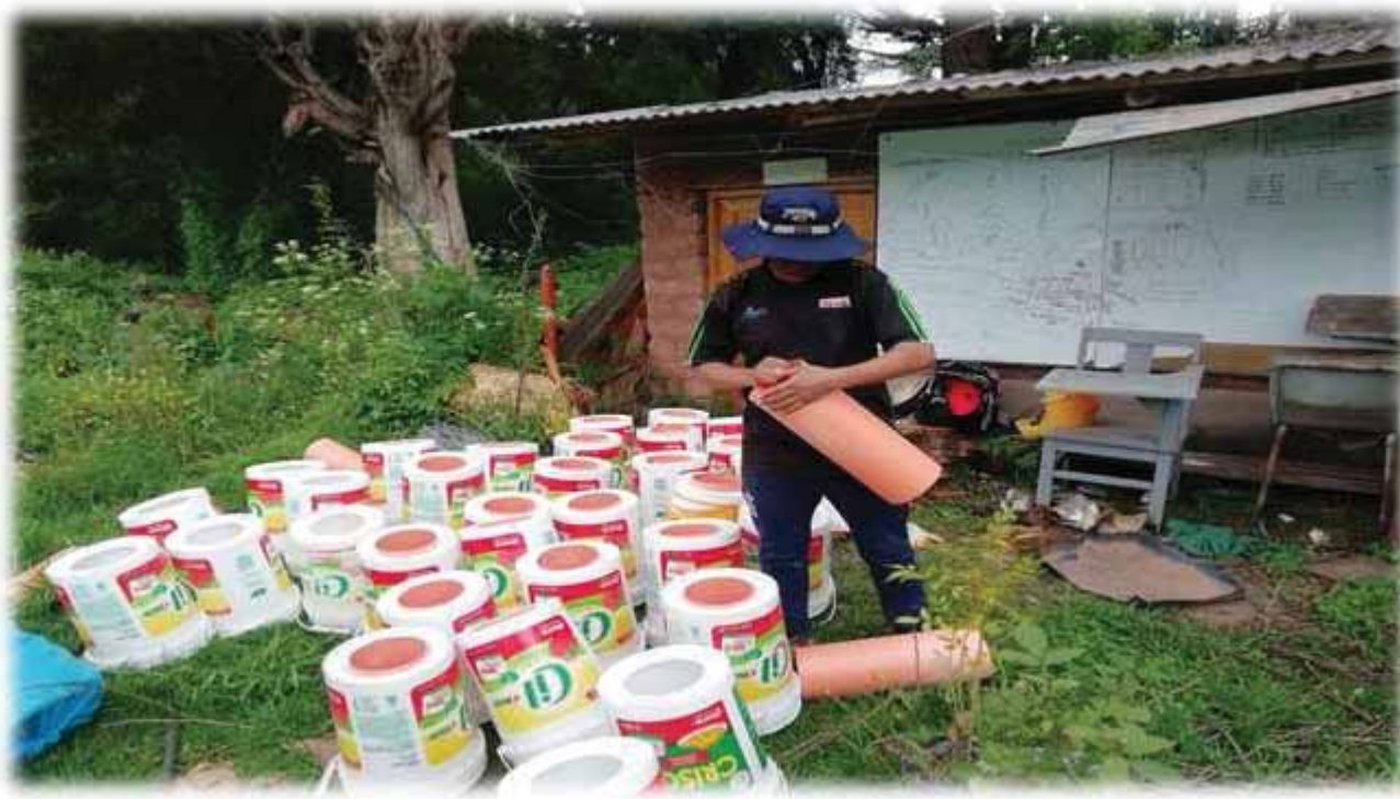
Fotografía N° 5: Proceso constructivo de la Yaka
