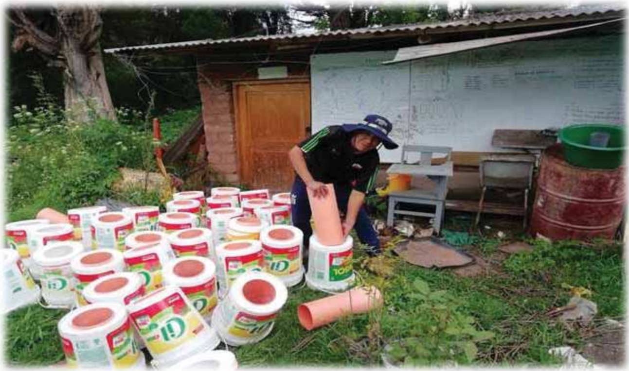
Fotografía N° 7: Colocado de tubería de 6" al envase.
