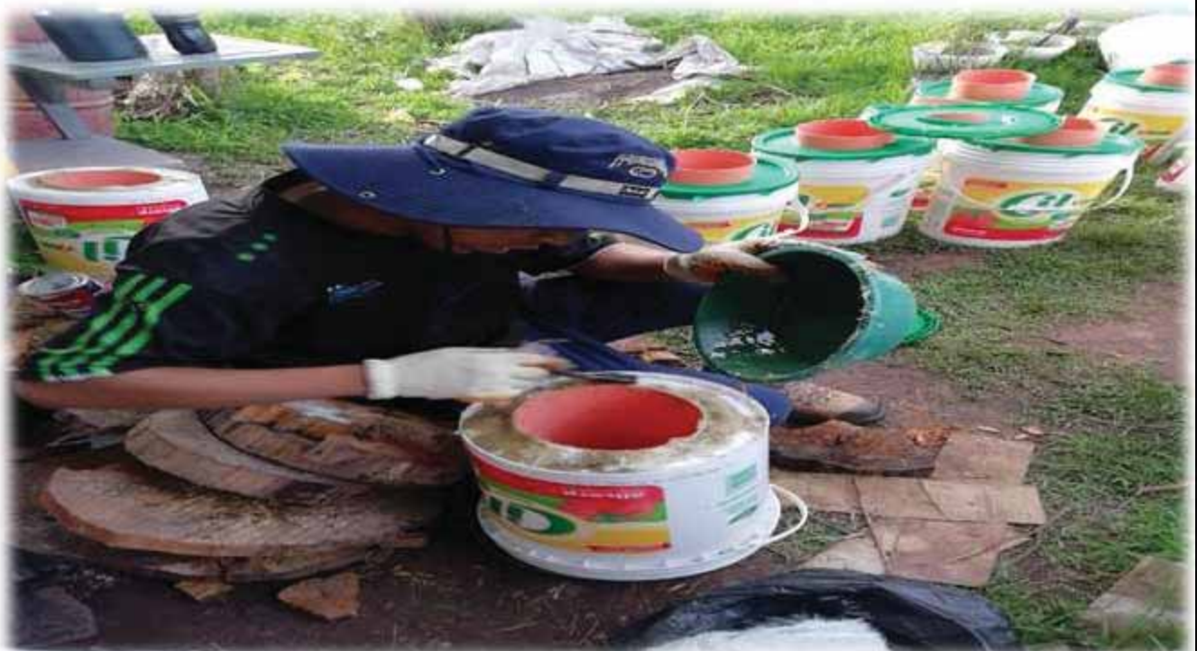
Fotografía N° 8: Proceso de pegado unión de balde con tubo de 6".
