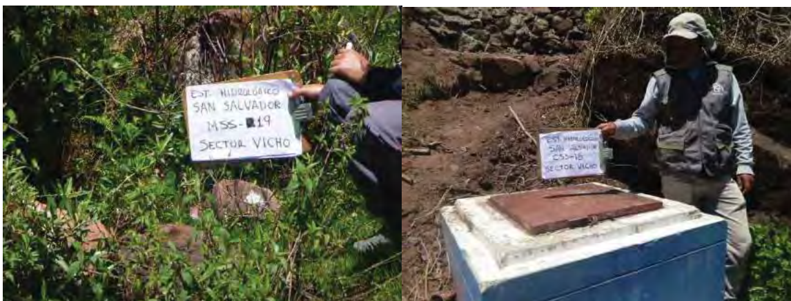
Foto N° 18 En la parte Izquierdo se puede apreciar el registro de manante que emana del suelo, en la parte derecha se puede apreciar que el manante está correctamente captado
