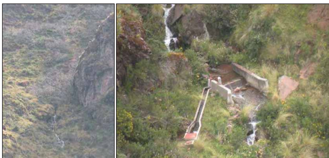
Foto N° 17 A la Izquierdo se observa que emana manante de fractura rocosa, en el lado derecho se aprecia la captación de los manantes nacientes en la cuenca de Parpacalle a 4000 m.s.n.m.
