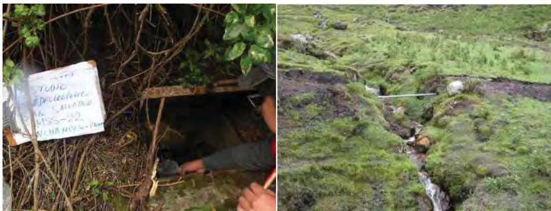
Foto N° 19 En la parte derecha se aprecia la captación de manante en la zona de Sinchahuayco en Pacor, en la parte derecha se puede apreciar que captan mediante canal desde Umachurco hacia el sector de Pacor.
