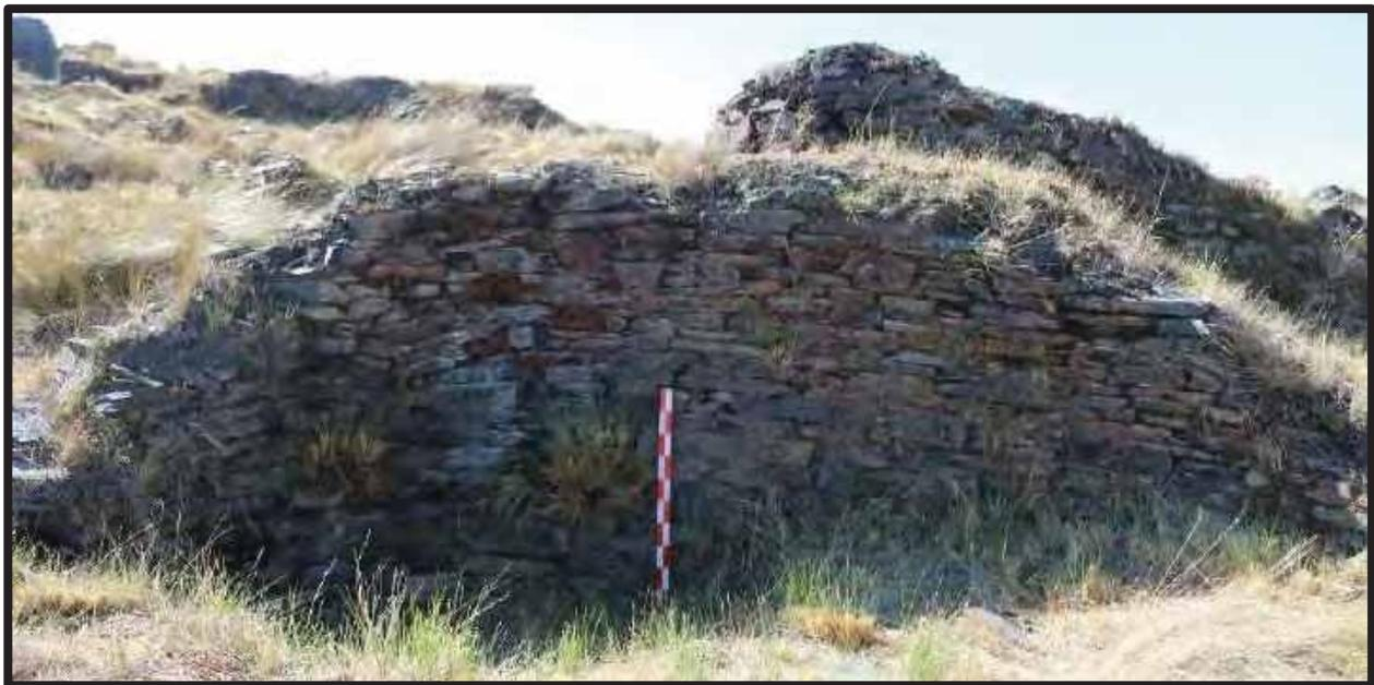
Figura 241: Mampostería ordinaria y aparejo irregular en paramento interior de la estructura Eg-24, Fuente: Propia.
