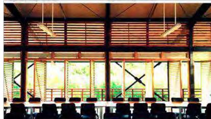
**Figura 83. Control de radiación en proyectos de selva**
