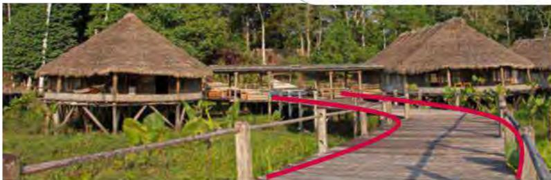
Los senderos se dan a través de plataformas o puentes de madera sujetadas sobre postes de madera.
