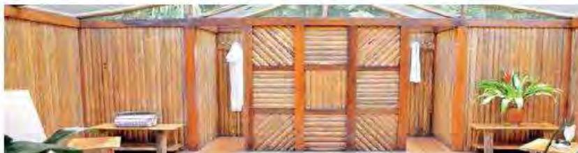
Muros de tabiquería con entramado vertical, diagonal de bambú
