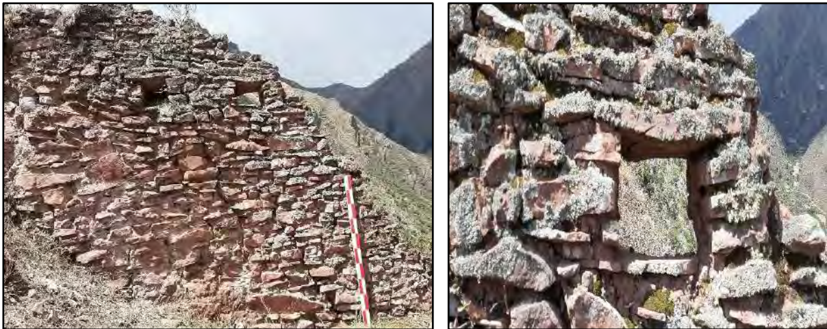
Foto 45 Se evidencia 02 ventanas en Estructura 09. Fuente (C. Pinares y M. Bravo)
