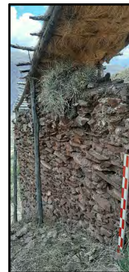
Muro norte (E 9)
