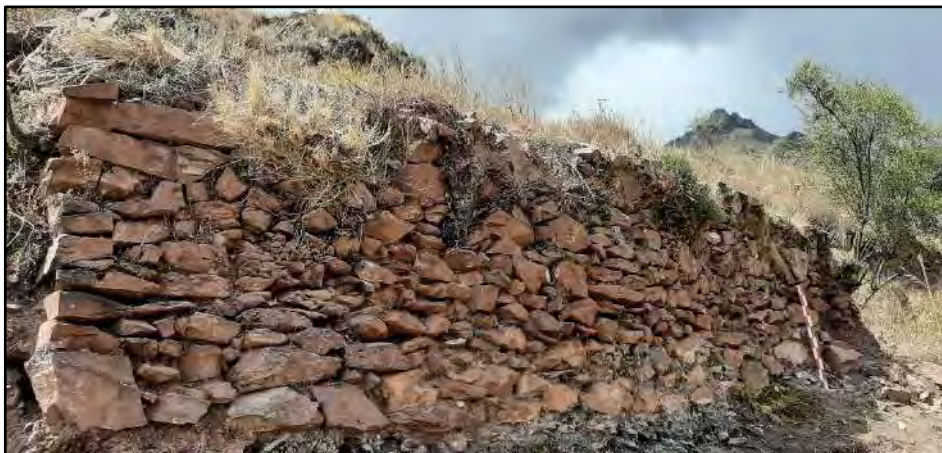
Foto 53 Aparejo rustico en Muros de Contención.
