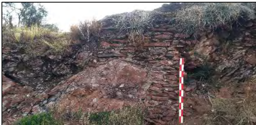
Foto 52 Muro de contención adosado y adecuado al afloramiento natural. Fuente: (C. Pinares y M.Bravo)
