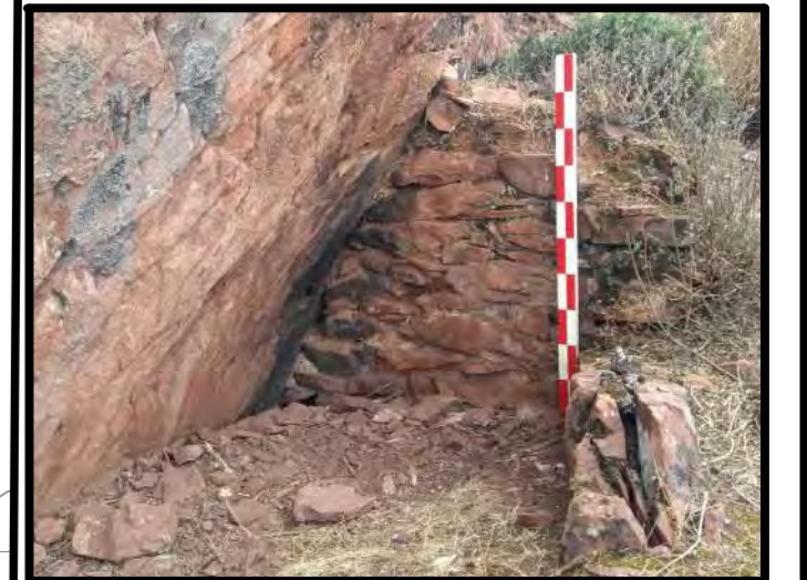
Estructura funeraria 1, muro norte interior
