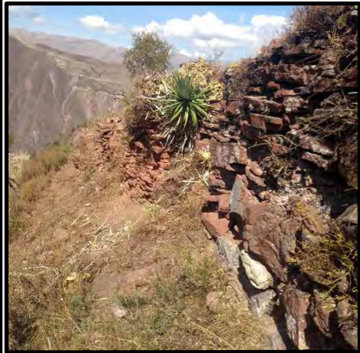
Muro de contención
