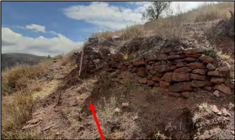
Muro de Contención 01
