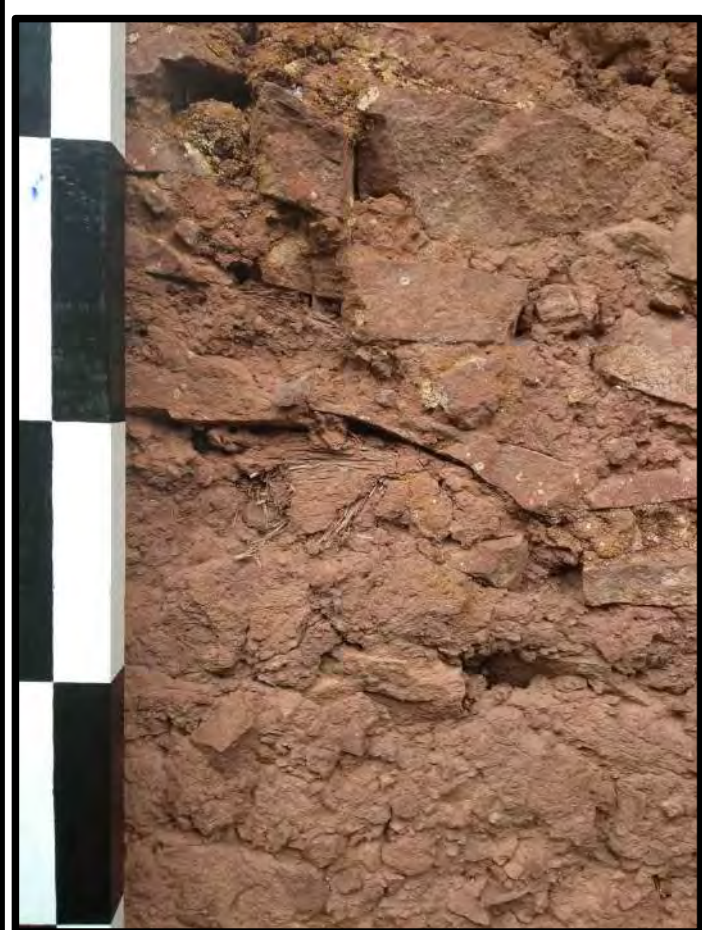
Tratamiento de enlucido
