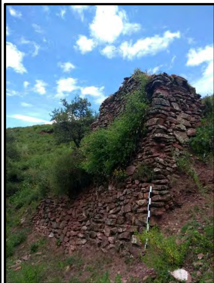
Muro este (E 12)
