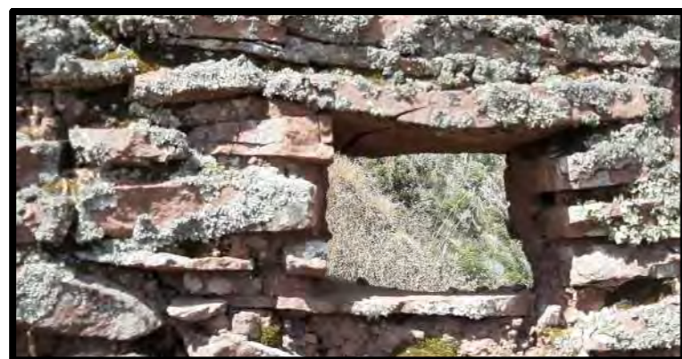
Vista de ventana (E 9)
