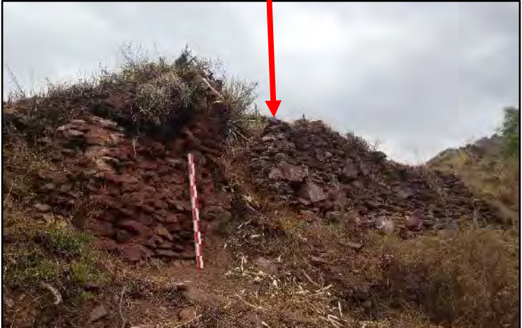
Imagen 10 Muro de Contención 01 y 02. Fuente: (C.Pinares y M.Bravo)
