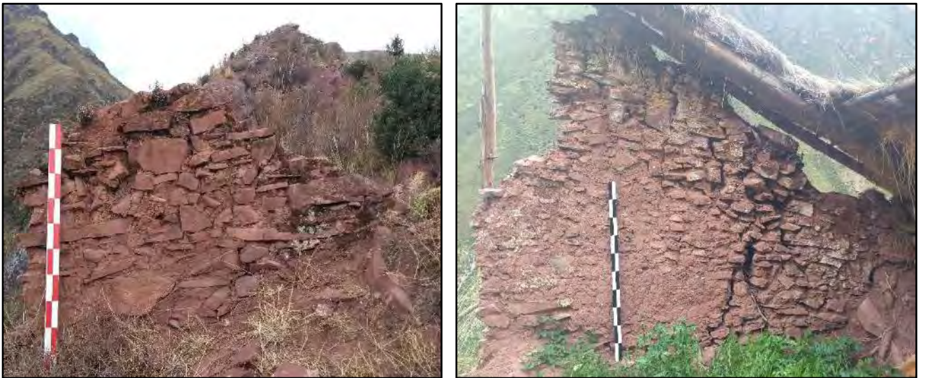
Imagen 63 Se observa el mortero utilizado para unir los elementos líticos. Fuente: (C.Pinares y M.Bravo)
