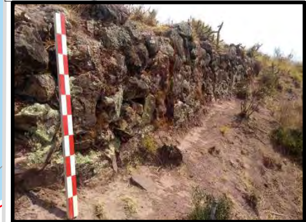
Muro NW Usnho
