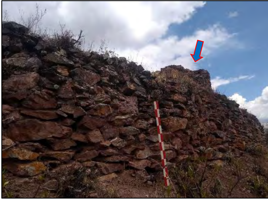
Foto 49 Estructura construida sobre muro de contención. Fuente: (C. Pinares y M. Bravo)
