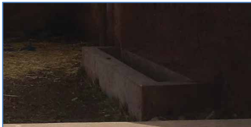
Figura 12. Bebedero estado actual en desuso.
