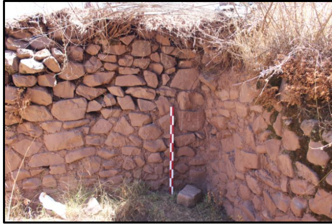
Foto 13. Muro construido con predominio del lítico tipo arenisca unida con mortero de barro. (Fuente Propia)
