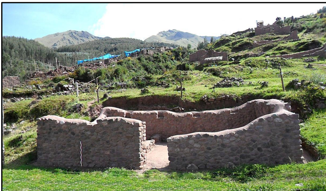
Foto 44. Vista general del recinto RA1 (Para mayor detalle ver ficha de registro arquitectónico N° 4 - Anexos). (Fuente Propia)
