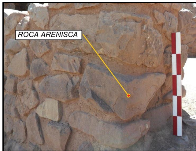
Foto 78. Utilización de roca arenisca de tamaños y formas variadas. (Fuente Propia)
