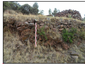
MURO DE CONTENCIÓN RELACIONADO A LOS RECINTOS CA7 - CA8, ESTE CONTRARRESTA LA PENDIENTE, A SU VEZ QUE GENERÓ UN ESPACIO NIVELADO, EL CUAL FUE COMPARTIDO POR LOS HABITANTES DE AMBOS RECINTOS
