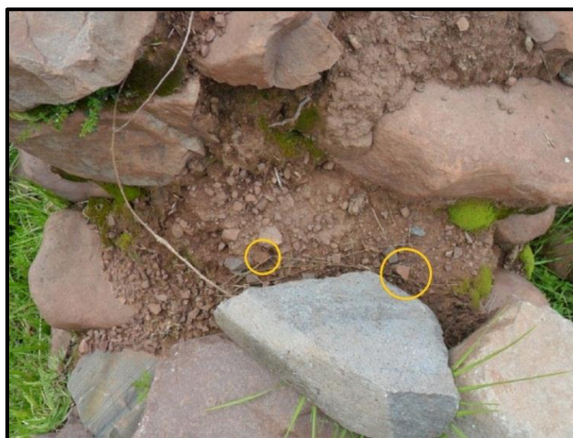
Foto 21. Mortero de barro con presencia de agregados de fragmentos de cerámica. (Fuente Propia)
