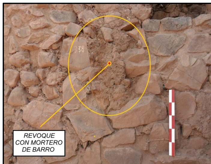
Foto 65. Revoque aplicado sobre el muro al interior del recinto. (Fuente Propia)
