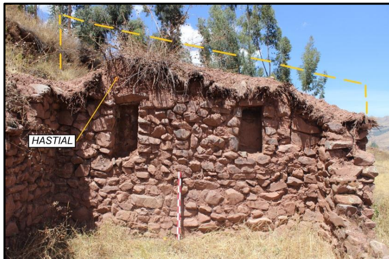
Foto 26. Hastial construido con adobe y mortero de barro, la clase de cubierta a una sola vertiente. (Fuente Propia)
