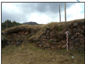
MURO DE CONTENCIÓN QUE GENERA UN ACONDICIONAMIENTO DEL ESPACIO, OPTIMIZANDO LA CIRCULACIÓN SUS HABITANTES ASÍ COMO PARA LA REALIZACIÓN DE ACTIVIDADES DIARIAS
