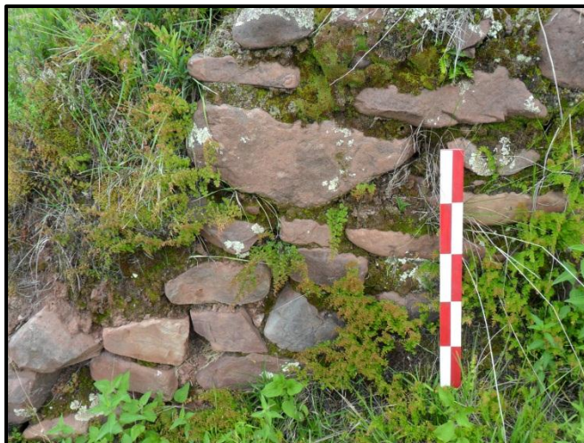
Foto 38. Tipo de aparejo rustico, disposición de líticas indistintamente de su tamaño y forma. (Fuente Propia)
