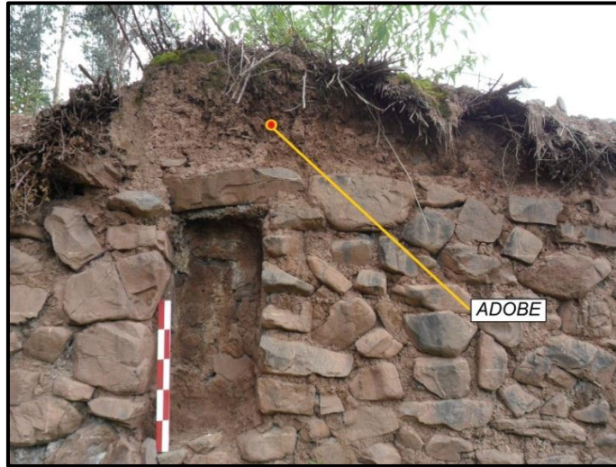
Foto 34. La utilización del adobe en la construcción de los hastiales de recinto. (Fuente Propia)
