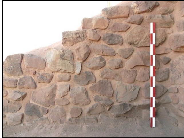
Foto 69. Muro construido con roca arenisca unida con mortero de barro. (Fuente Propia)
