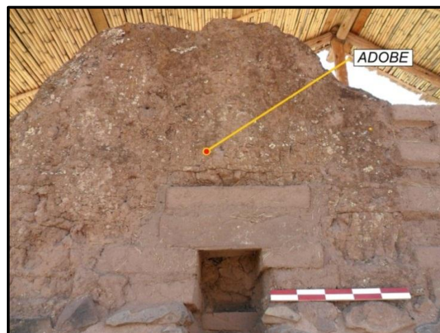
Foto 79. Utilización de adobe en hastiales así como en partes de las hornacinas del recinto. (Fuente Propia)
