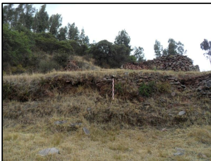
Foto 43. Muro de contención el cual contrarresta la pendiente del terreno. (Fuente Propia)
