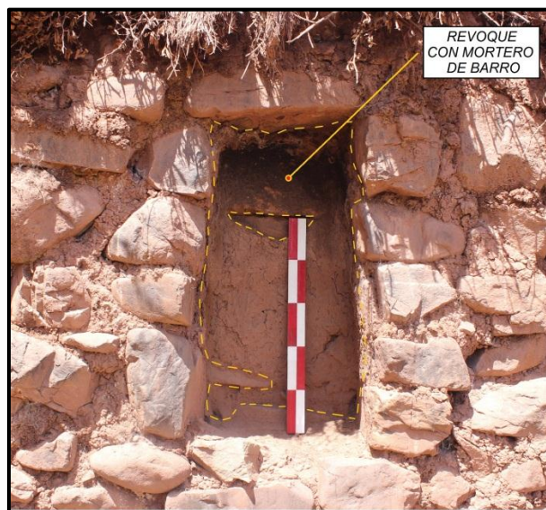
Foto 30. Acabado mediante revoque de mortero de barro al interior de una de las hornacinas. (Fuente Propia)
