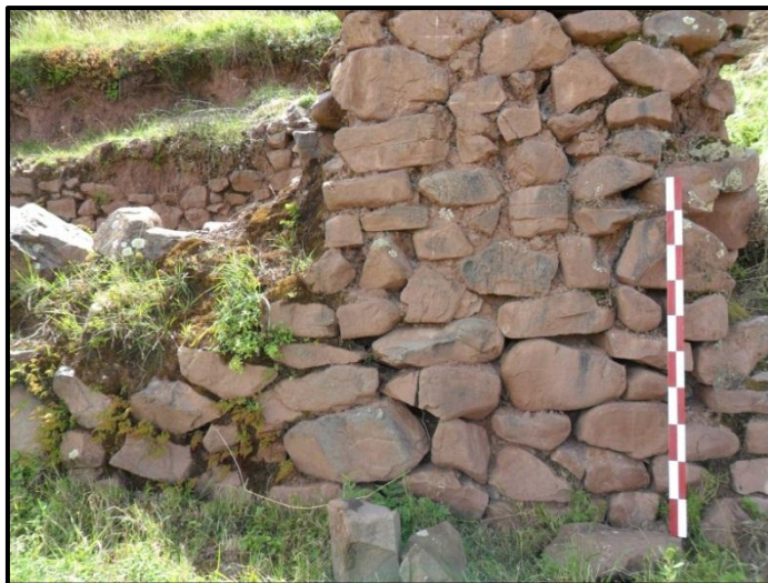
Foto 27. El muro presenta forma de aparejo natural. (Fuente Propia)
