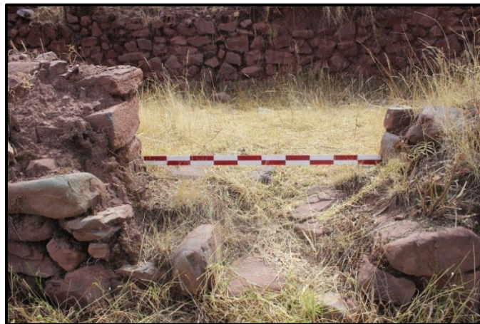
Foto 24. Disposición de líticos cuyas características fueran adecuadas para las esquinas del vano de acceso. (Fuente Propia)
