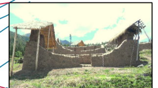
RECINTOS RA16 ES UNO DE LOS POCOS QUE AUN HAN CONSERVADO PARTE DEL HASTIAL, POR EL CUAL DEFINIMOS EL TIPO DE CUBIERTA A DOS AGUAS
