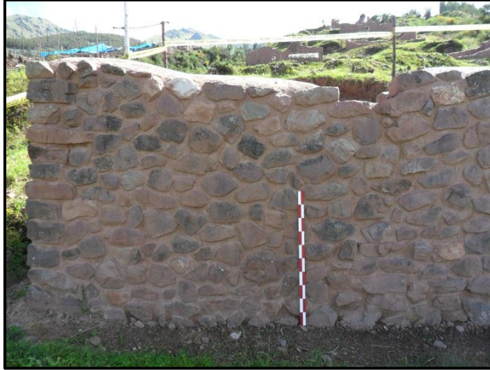
Foto 45. Predominio del lítico tipo arenisca en la construcción de los muros del recinto. (Fuente Propia)
