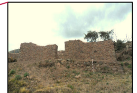
EVIDENCIAMOS LA CONSTRUCCIÓN DE MUROS DE CONTENCIÓN EN ÁREAS DONDE EL RECINTO REQUIERE GARANTIZAR SU ESTABILIDAD
