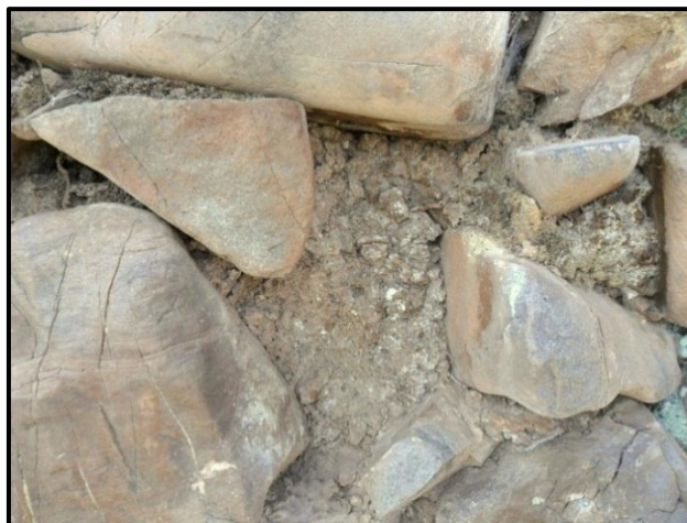
Foto 86. Mortero de barro entre los elementos líticos conformantes del muro del recinto. (Fuente Propia)
