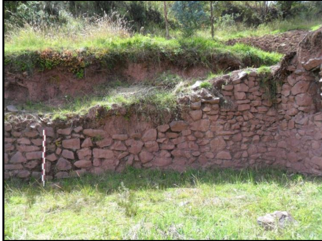
Foto 23. La utilización en gran medida de roca arenisca unida con mortero de barro. (Fuente Propia)
