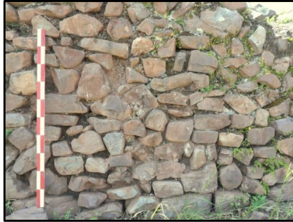
Foto 83. Muro del tipo de aparejo rustico y forma de aparejo natural. (Fuente Propia)
