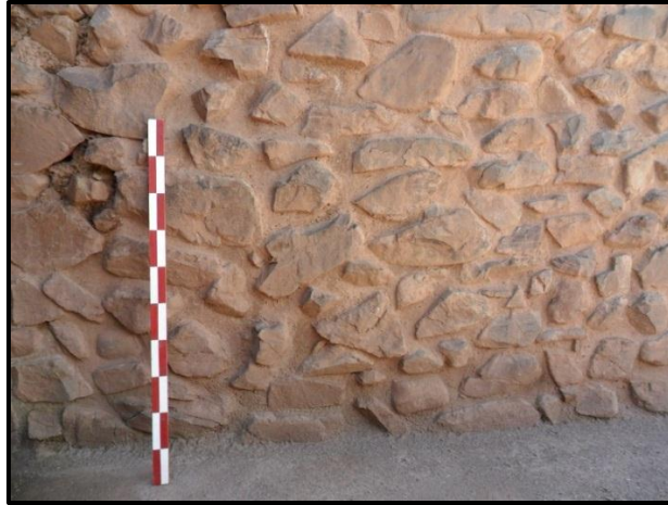
Foto 57. Muro construido con predominio de roca arenisca de tamaños y formas variadas. (Fuente Propia)
