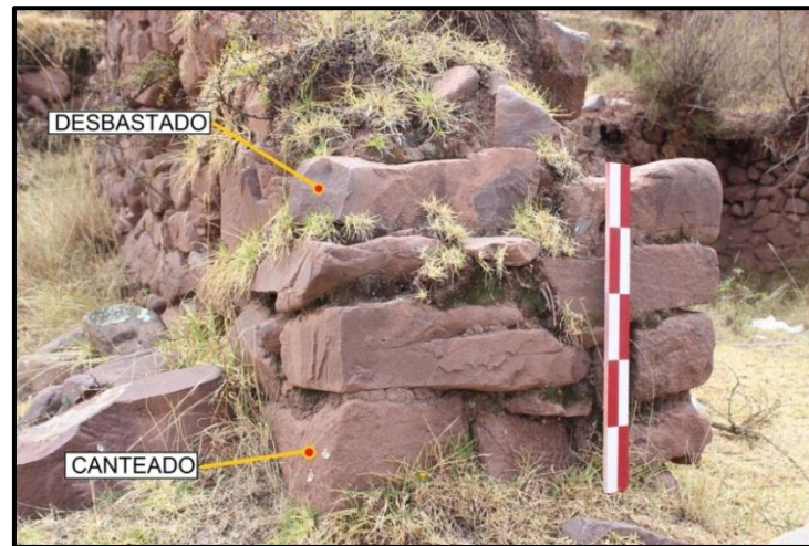
Foto 18. Trabajo canteado y desbastado en elementos líticos que fueron dispuestos en el vano de acceso. (Fuente Propia)
