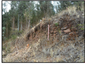
MURO DE CONTENCIÓN HALLADO EN RELACION A LOS RECINTOS RB16 - RB20
