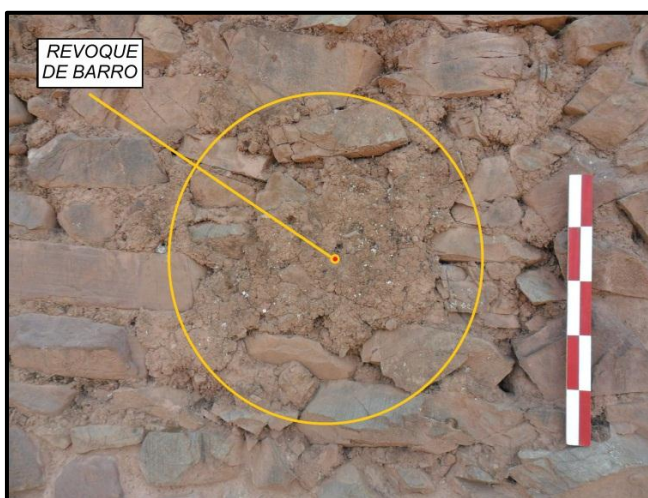
Foto 77. Técnica de revoque de barro aplicada en el muro exterior del recinto RA23. (Fuente Propia)
