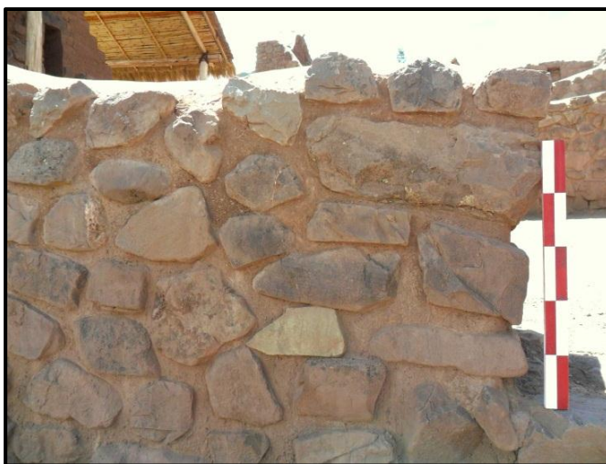
Foto 73. Se aprecia el tipo de aparejo rustico asi como la forma de aparejo natural. (Fuente Propia)
