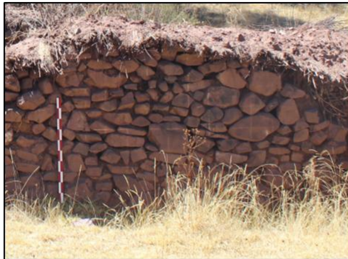
Foto 17. Elementos líticos de diversas dimensiones dispuestas indistintamente en el proceso constructivo, dando como resultado un tipo de aparejo rustico. (Fuente Propia)
