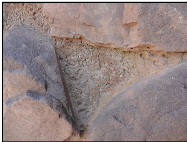
Foto 55. Mortero de barro utilizado para la union de liticos conformantes del muro. (Fuente Propia)
