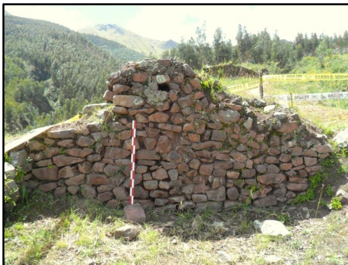
Foto 82. Muro lateral construido en base a roca arenisca unida con mortero de barro. (Fuente Propia)
