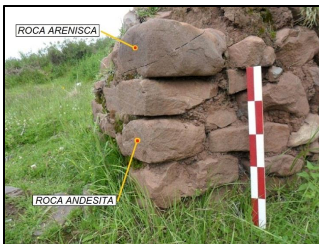
Foto 20. Se observa la presencia de líticos del tipo arenisca y andesita. (Fuente Propia)
