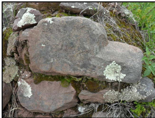
Foto 41. Utilización del lítico tipo arenisca de tamaños y formas variadas. (Fuente Propia)
