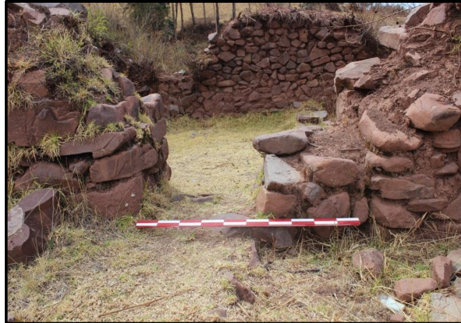
Foto 15. Presencia de tapiado en parte del vano de acceso del recinto. (Fuente Propia)
