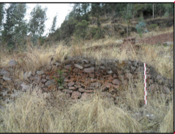
MURO DE CONTENCIÓN RELACIONADO A LOS RECINTOS CA3 - CA4
