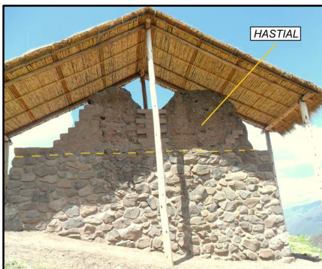
Foto 72. Hastiales construidos en base a adobe y mortero de barro. (Fuente Propia)
