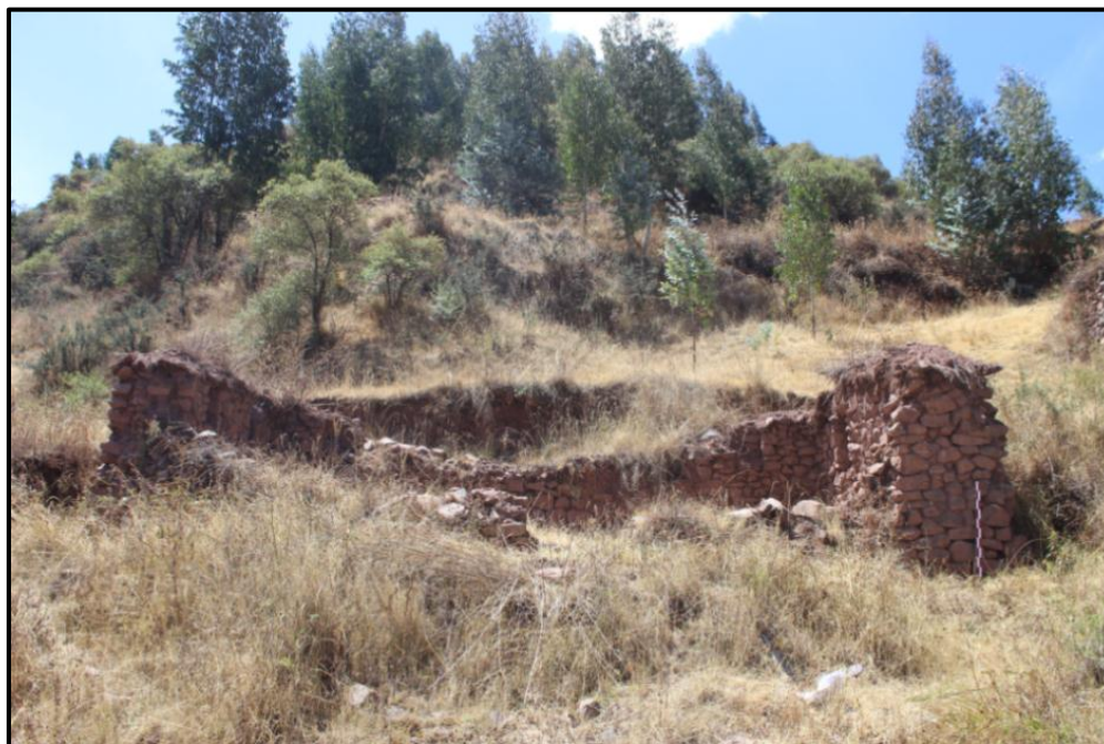
Foto 22. Vista general del recinto CA4, así como su estado actual de conservación (Para mayor detalle ver ficha de registro arquitectónico N° 2 - Anexos). (Fuente Propia)
