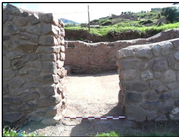
Foto 47. Vano de acceso orientado con tendencia al sur. (Fuente Propia)
