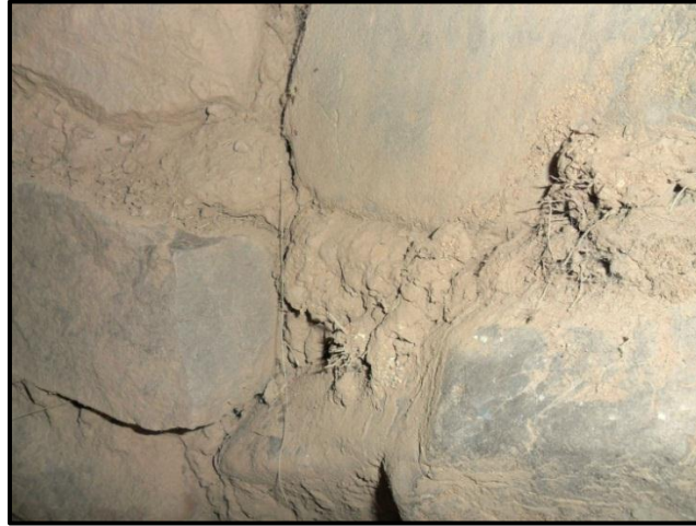
Foto 80. Mortero de barro utilizado entre los líticos. (Fuente Propia)
