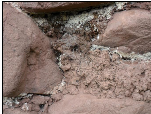
Foto 33. Mortero de barro utilizado para la construcción del recinto. (Fuente Propia)
