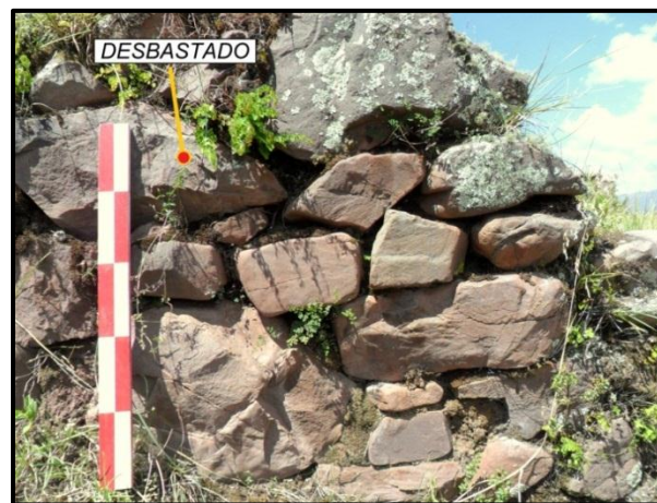
Foto 84. Se aprecia el nivel de trabajo desbastado de algunos elementos líticos. (Fuente Propia)
