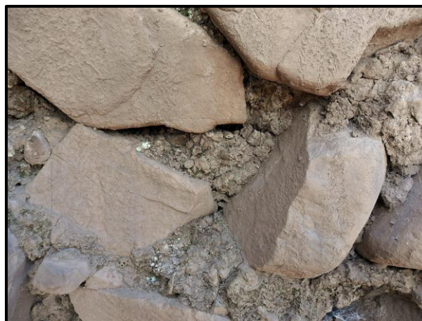
Foto 67. Mortero de barro aplicado entre los elementos líticos, dentro del proceso constructivo del recinto. (Fuente Propia)
