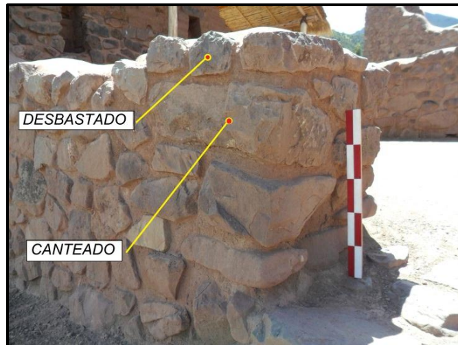
Foto 74. Nivel de trabajo desbastado y canteado aplicado sobre algunos elementos líticos. (Fuente Propia)
