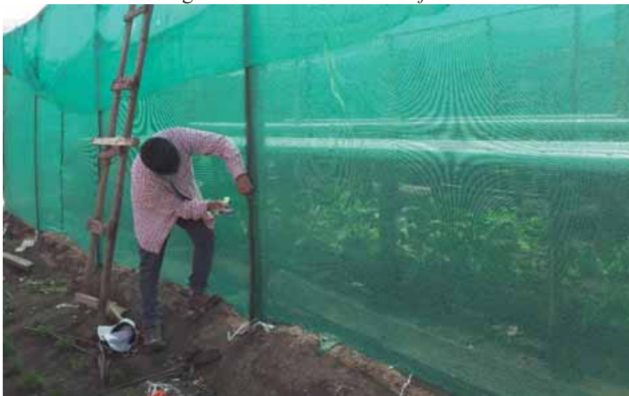
Fotografía 2: Construcción del fitotoldo
