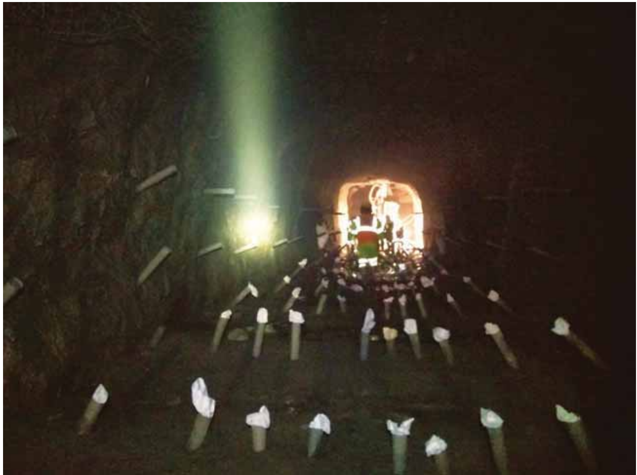
Ilustración 42. Perforación de taladros descendentes Tj 1553 en el Nv4012.
