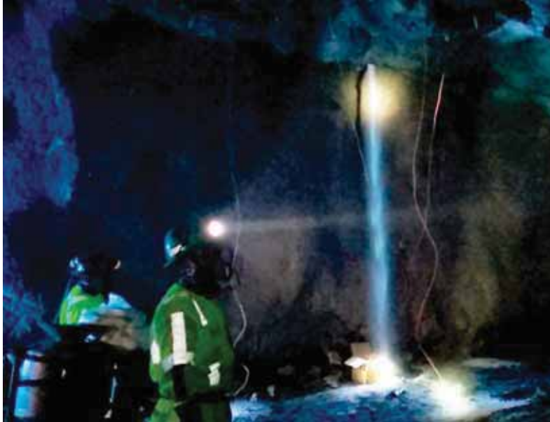
Ilustración 35. Caída de Anfo en taladros ascendentes de 89mm de diámetro.
