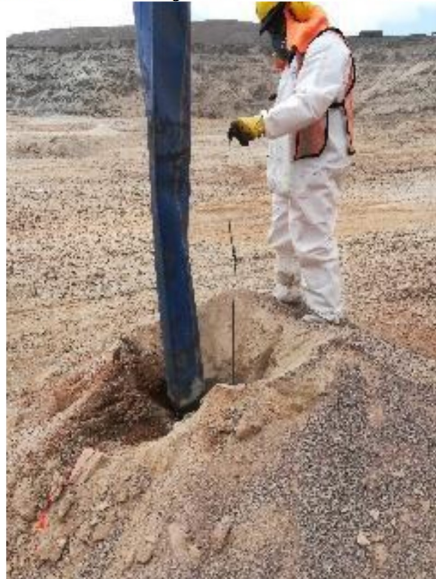
Figura 37.- Trabajador Wincheando el Taladro
