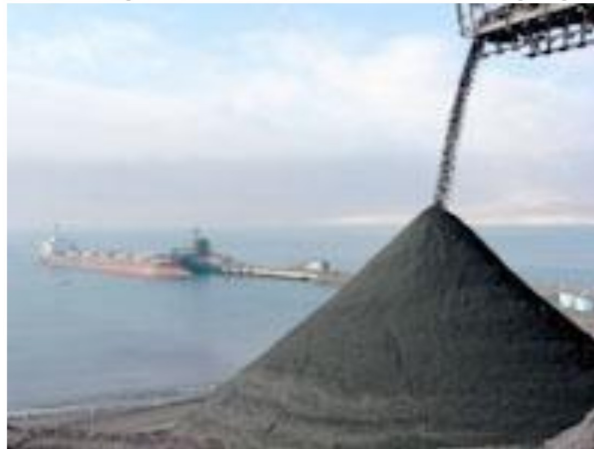
Figura 50.- Zona de Filtrado, Shougang
