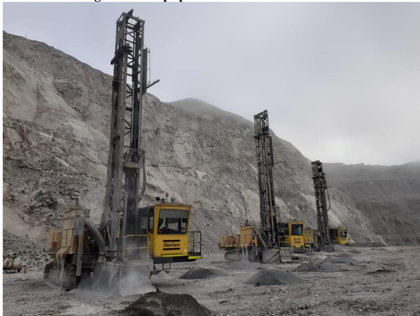
Figura 34.- Equipos de Perforación de Diámetro 9”
