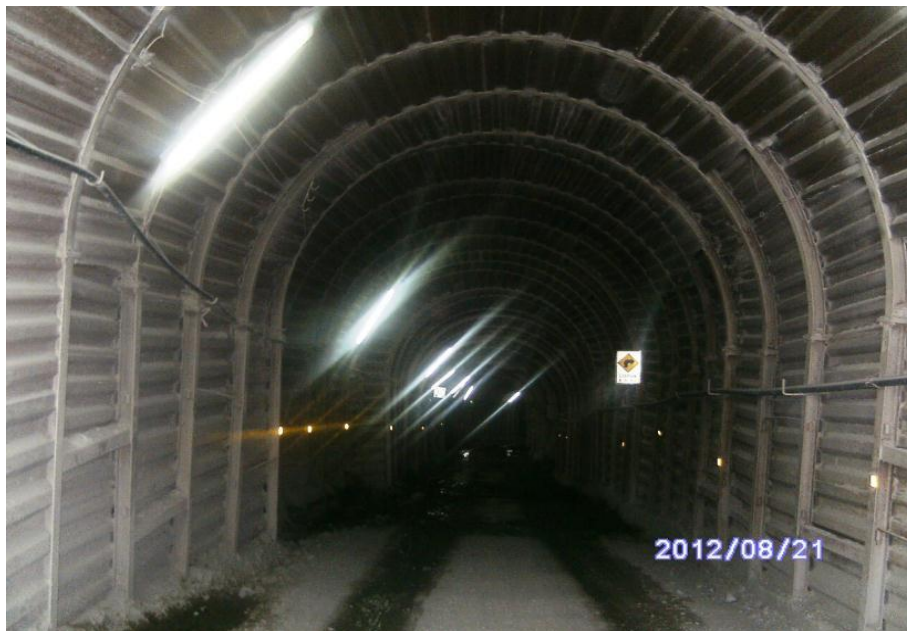
Imagen 4.23 – Cimbras Metálicas BP –1767.
