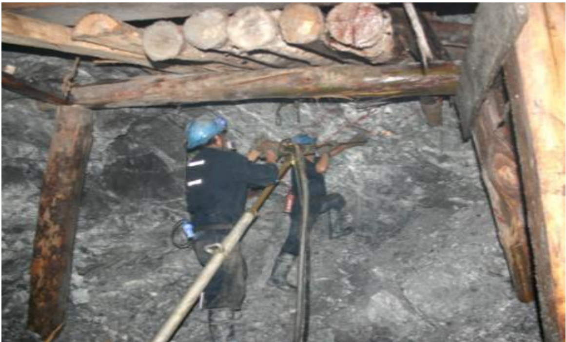
Imagen 4.21 – Perforación con Maquina Jack Leg. TJ – 628 Mina Rosa.
