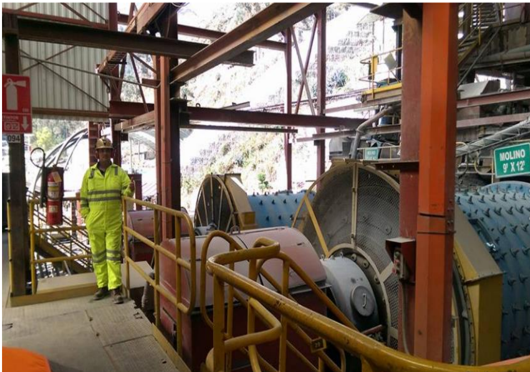
Figura N° 3.4: Planta de tratamiento de mineral aurífero de C.M.H.S.A.
