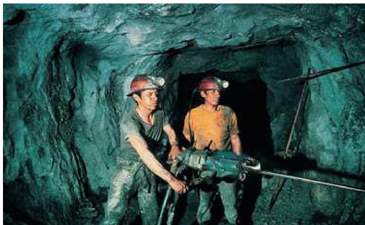
Figura 4.1. Perforación convencional jackleg
