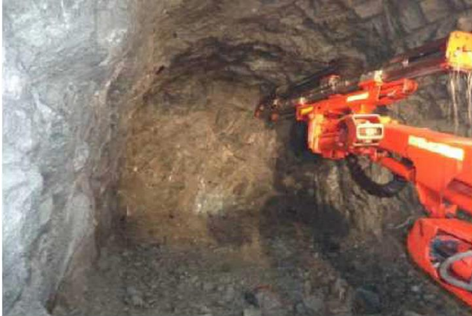
Figura 4.2. - Perforación Mecanizada con Jumbo Sandvik DD311
