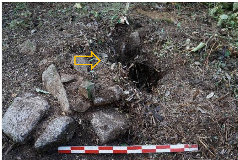
Figura 31. Vista del recinto con detalle de alteración de paramento por acciones de agente del deterioro antrópico. Foto: Raúl Sota Flórez.
