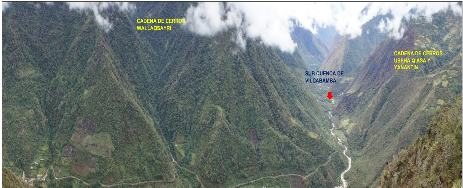
Figura 6. Vista de la cadena de cerros que flanquea por la parte norte la zona de estudio y la sub cuenca de Vilcabamba. Foto: Raúl Sota Flórez.
