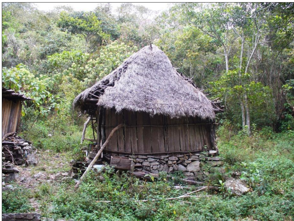
Figura 125. Vivienda contemporánea con estructura de planta circular completado con el uso de otros elementos arquitectónicos. Foto: (Gonzales y Gonzales, 2012, p. 104).
