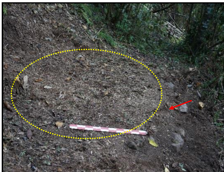
Figura 43. Vista donde se observa segmento de muro a nivel de cimentación. Foto: Raúl Sota Flórez
