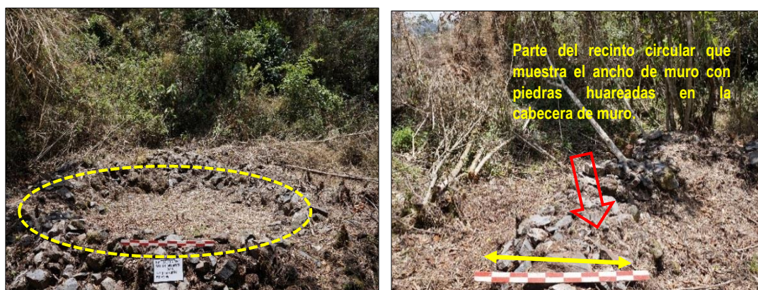
Figura 86. Nótese las fotos de la estructura completa y su ancho de muro. Foto: Raúl Sota Flórez.
