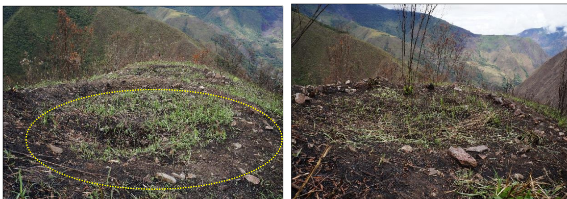
Figura 113. Las imágenes muestran fotografías panorámicas del recinto circular con su arquitectura de mampostería ordinaria, también se da a conocer que todo este conjunto de recintos circulares en la actualidad se hallan en mal estado de conservación. Foto: Raúl Sota Flórez.
