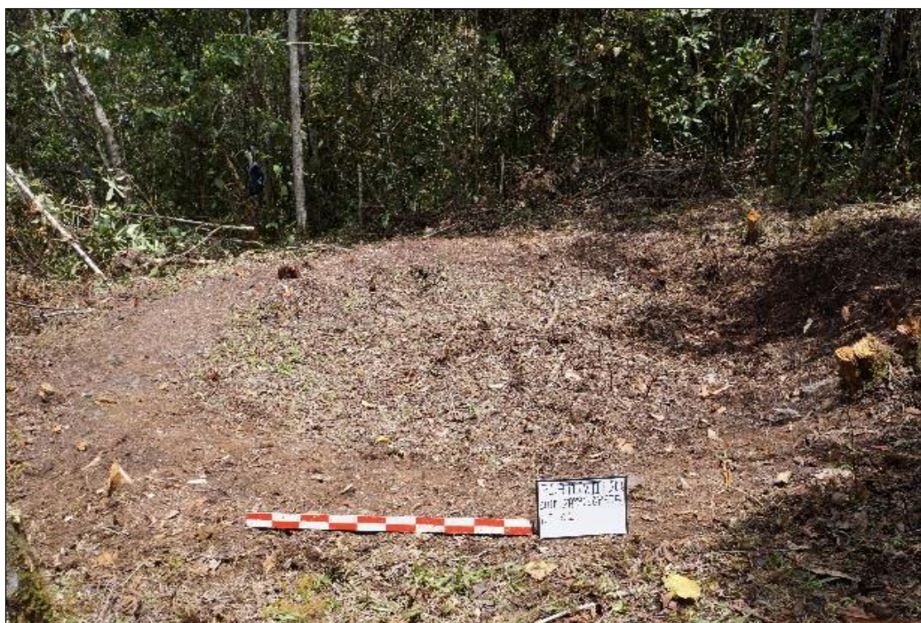
Figura 126. Ejemplo de plataforma circular excavada en pendiente, en proceso de construcción. Foto: Raúl Sota Flórez.
