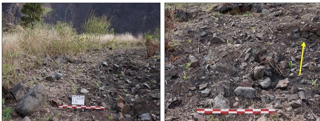
Figura 104. Se muestra en esta arquitectura el patrón constructivo de dos hileras en el muro y el uso de mortero en su núcleo. Foto: Raúl Sota Flórez.
