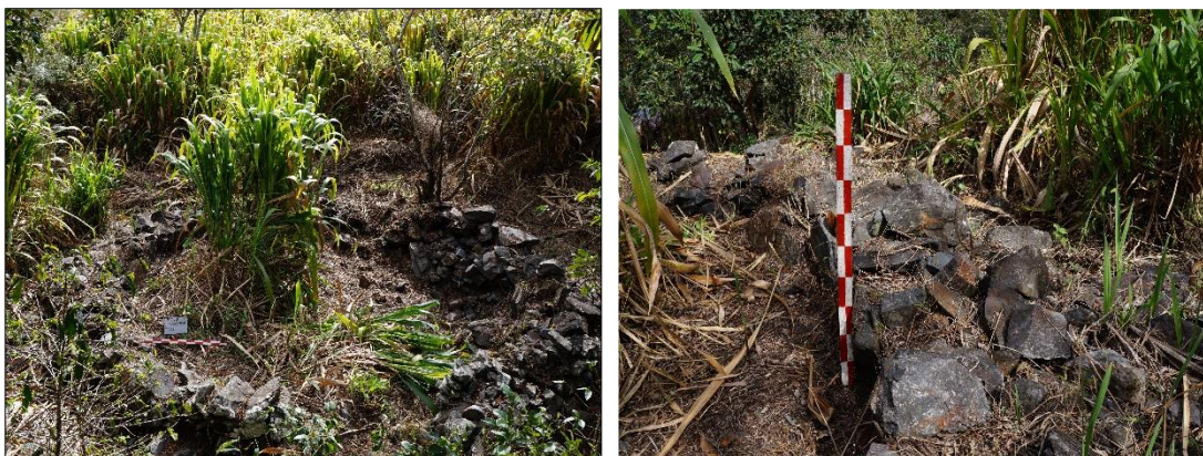
Figura 101. Recinto en la cual se muestra la ocupación de actividad agrícola como también se observa detalles constructivos. Foto: Raúl Sota Flórez.
