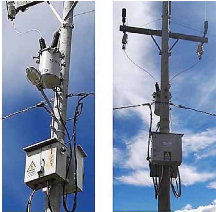
Fotografía 21. SED 0041982 (bifásica) – Condorpampa (izquierda) tablero existente, (derecha) tablero SED TWACS instalado
