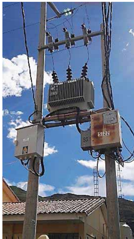
Fotografía 19. SED 0040073 (trifásica) – Checacupe 1 (izquierda) tablero SED TWACS instalado, (derecha) tablero existente
