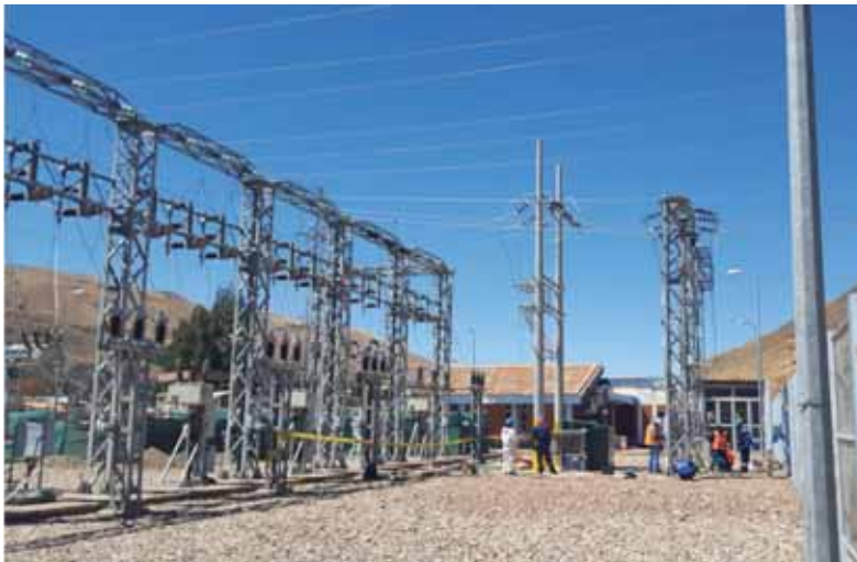
Fotografía 5. Montaje de Equipos en SET
