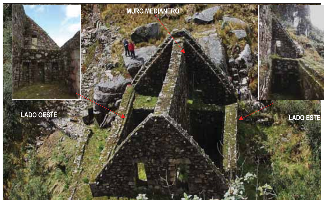
Figura 2922. Adoratorio de altura, de dos niveles y dos ambientes (lado Este y Oeste) divididos por un muro medianero.
