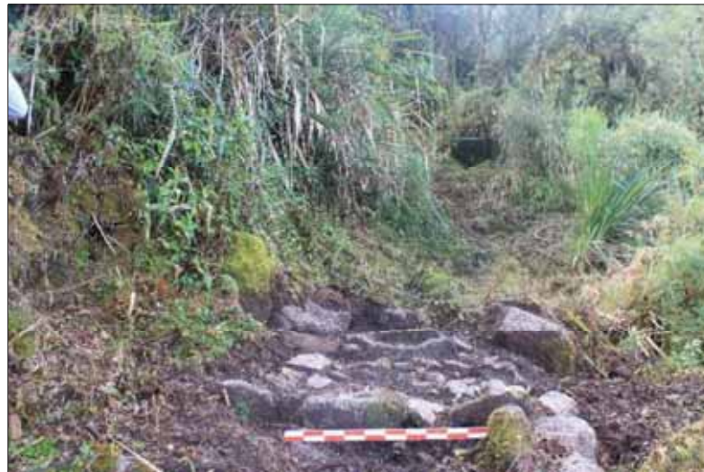
Figura 27. Camino empedrado en corte talud.
