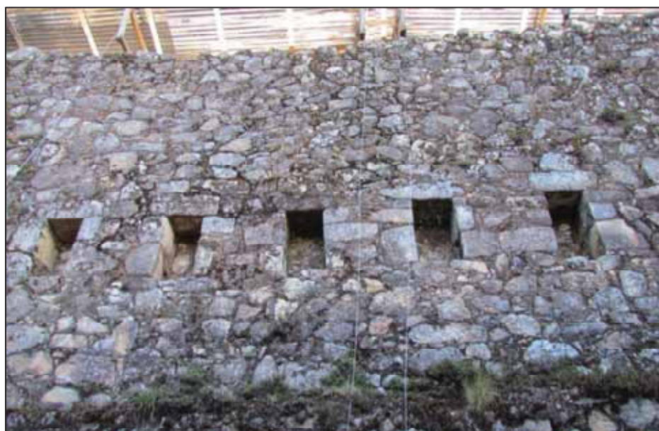
Figura 136. Distribución de los nichos ubicados en el muro medianero del segundo nivel, lado Este.
