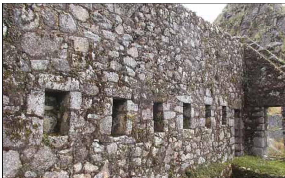
Figura 3431. Distribución de los nichos en el muro medianero del segundo nivel, ubicado en el lado Oeste.
