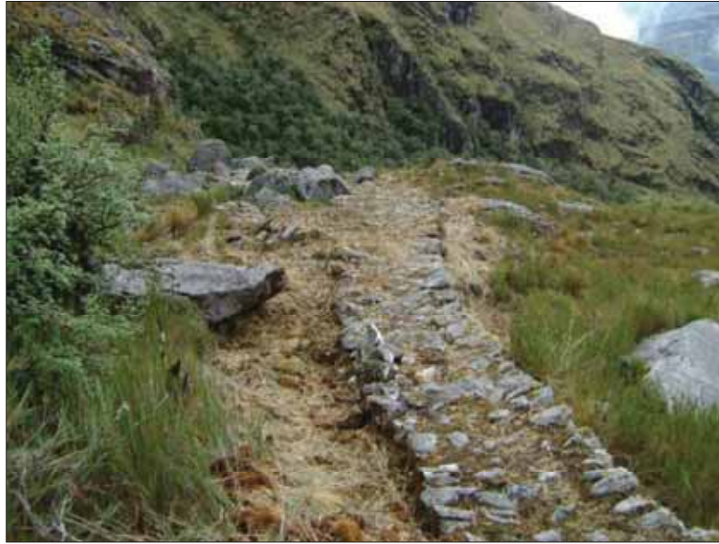
Figura 77. Camino ritual construido formalmente de calzada elevada.
