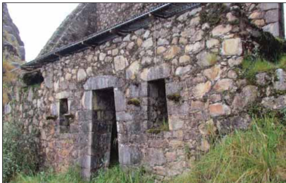
Figura 135. Detalles arquitectónicos del exterior del espacio Este, se observa dos ventanas de forma trapezoidal ubicadas a cada lado del vano de acceso, cada ventana tiene dos clavijas una a cada lado.
