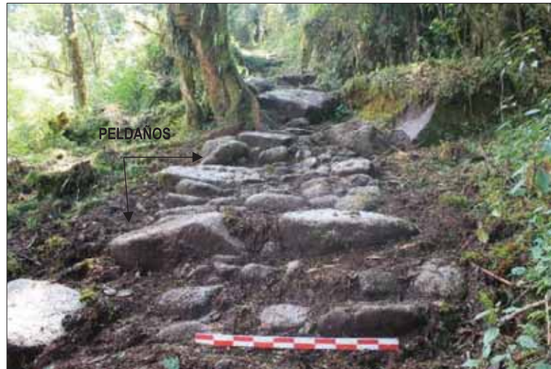
Figura 25. Camino con escalinatas y empedrado en regular estado de conservación.
