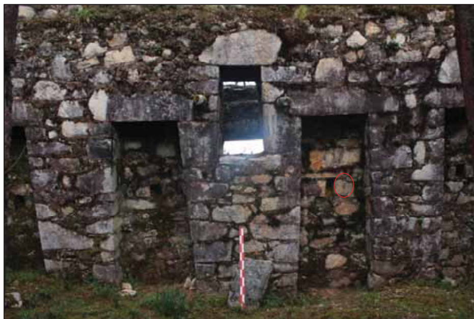
Figura 3330. Muro medianero con ventana que intercomunica el espacio Oeste y Este con sus clavijas, y los nichos de cuerpo entero con sus argollas líticas en la primera planta.
