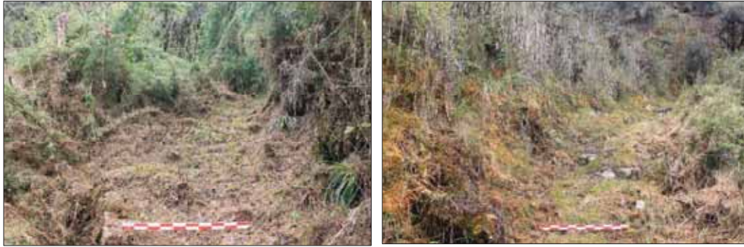
Figura 59. Camino ritual con plataforma (corte de talud), afectado por la vegetación de la zona.
