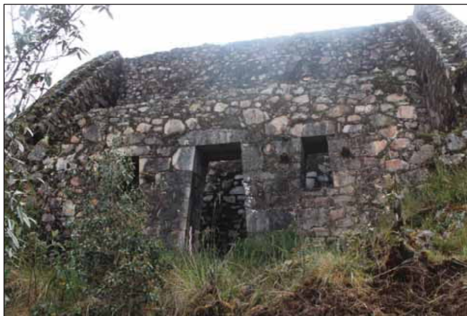
Figura 3633. Fachada Este, del espacio de dos niveles.
