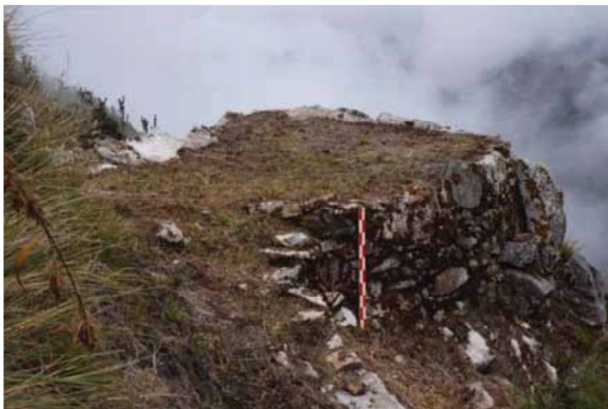
Figura 179. Detalle de la altura del muro de sostenimiento.
