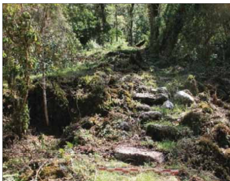
Figura 23. Camino con escalinatas en mal estado de conservación, se ubica en el sector de Ranrapata.
