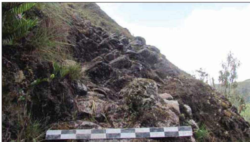
Figura 279. Camino en proceso de construcción sobre afloramiento rocoso.
