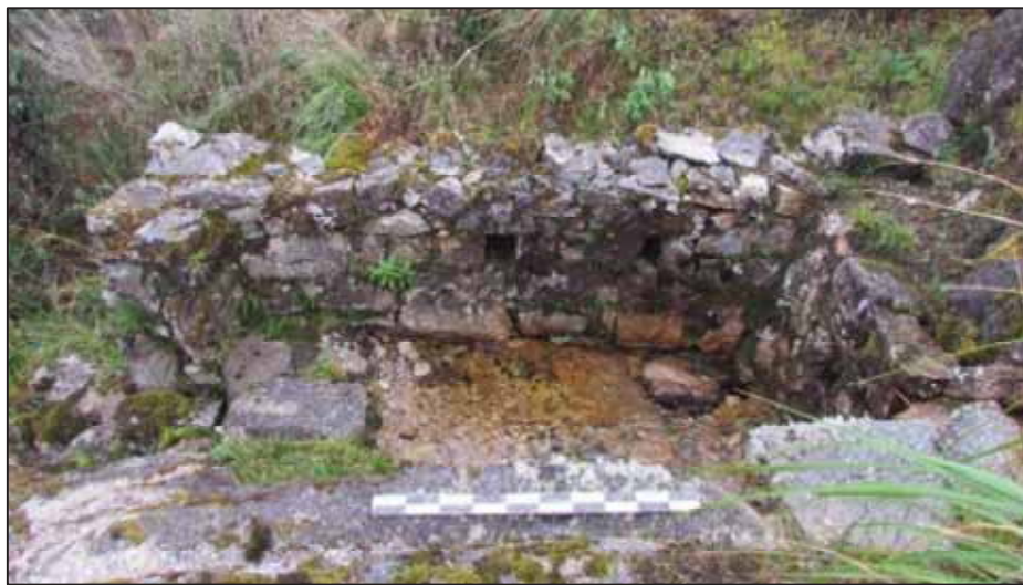
Figura 95. Detalle del ingreso y el interior del pozo con cajuelas empotradas en el muro interior.
