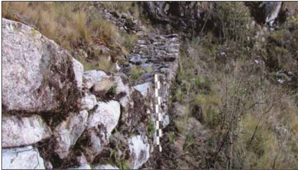
Figura 83. Detalle de la altura de muro de sostenimiento del terraplén.
