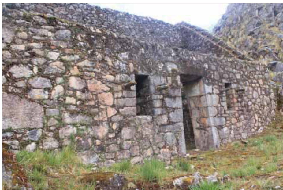
Figura 126. Detalles arquitectónicos del exterior de la primera planta (espacio Oeste), con vano de acceso y ventanas con sus respectivas clavijas.
