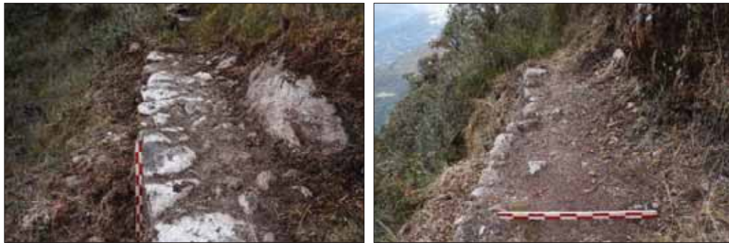
Figura 149. Corresponden a camino en plataforma corte de talud con muro de sostenimiento terraplén.
