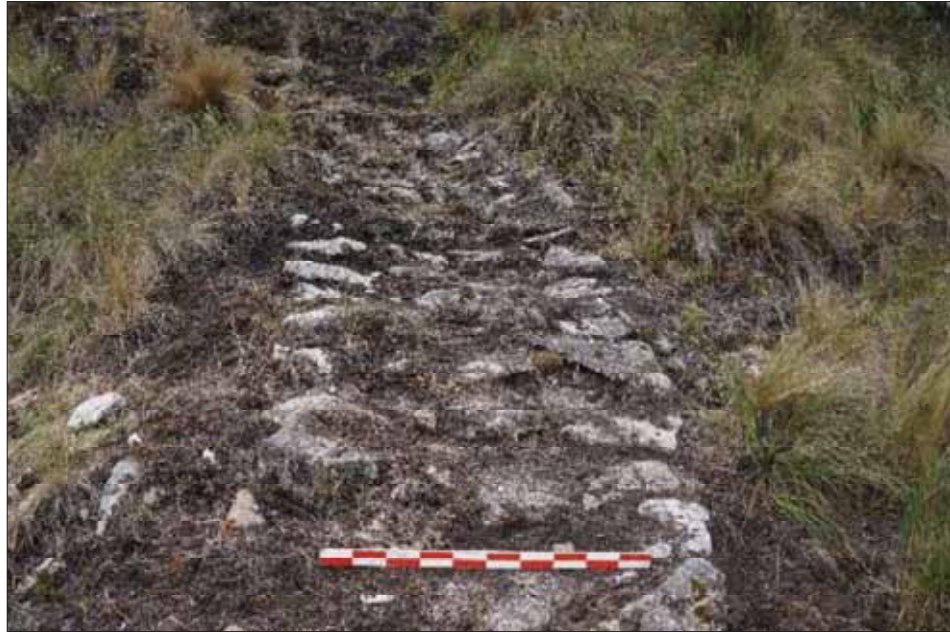
Figura 103. Camino empedrado con piedras maestras laterales.
