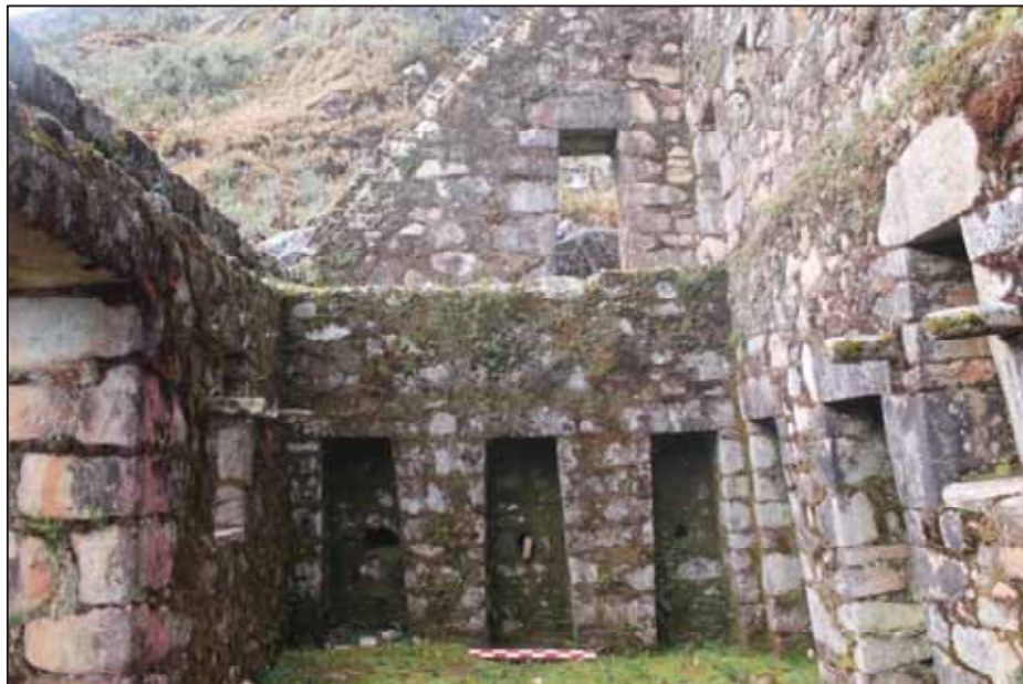
Figura 129. Detalles arquitectónicos del interior de la primera planta (espacio Oeste), con nichos de cuerpo entero y argollas líticas en su parte media, y en la derecha (muro medianero) e izquierda de la figura las ventanas con sus clavijas.
