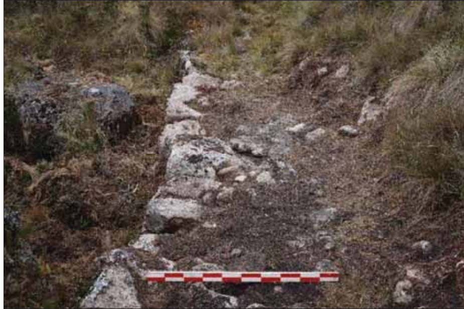
Figura 2214. Camino ritual formalmente construido de plataforma corte de talud con muros de sostenimiento terraplén.
