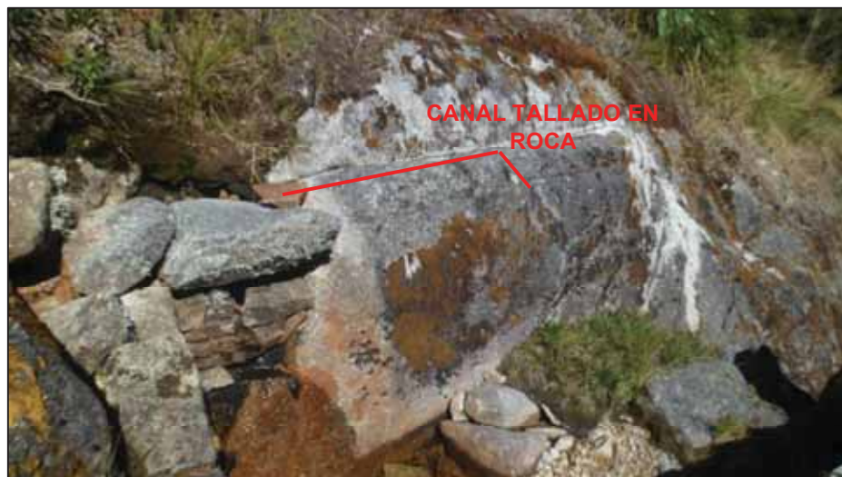
Figura 97. Vista del canal tallado en roca.
