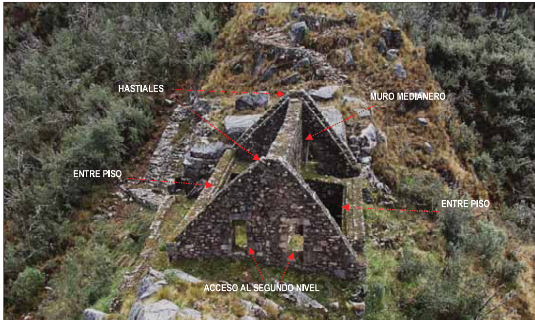
Figura 3532. Detalles arquitectónicos del segundo nivel: se observa de los cuatro vanos de acceso al segundo nivel ubicados en los hastiales (lado Sur y Norte), el entre piso y el muro medianero que divide ambos ambientes (lado Este y Oeste).
