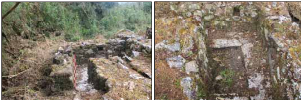
Figura 52. Vease al extremo izquierdo vista general de la fuente de agua. A la derecha véase el detalle del interior con pozo y cajuela empotrado en el muro interior.
