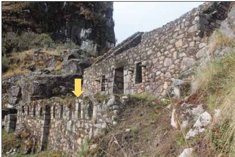
Figura 141. Muro de contención al Oeste del adoratorio de altura.
