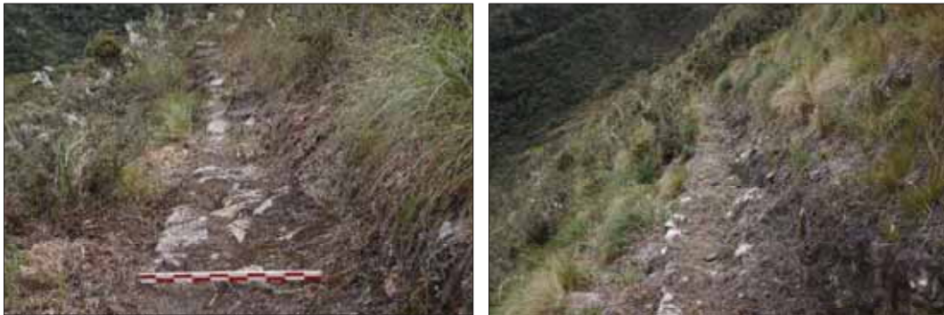
Figura 105. Camino en plataforma con muro de sostenimiento terraplén.
