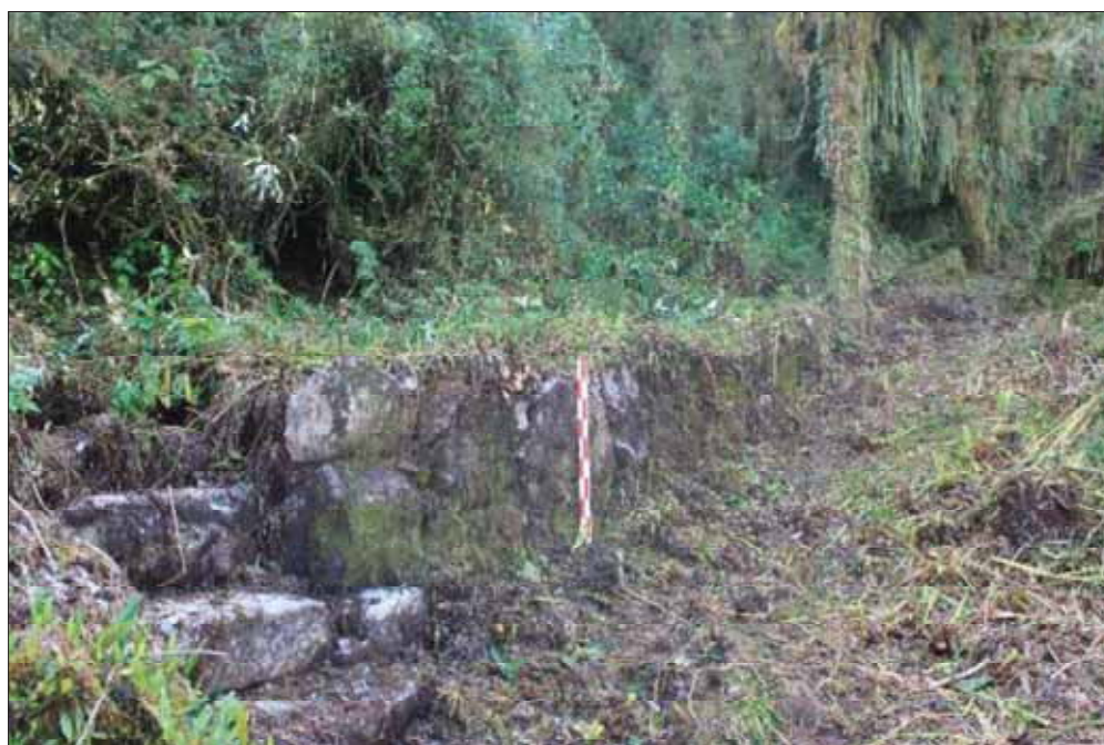
Figura 42. Vista en primer plano del muro de sostenimiento de la plataforma, lado izquierdo inferior de la figura; acceso a la plataforma mediante escalinata.
