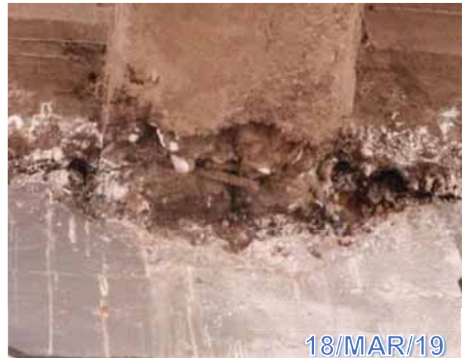
Figura 13: a) Eflorescencia y Acero expuesto en la V.P.C en ambos carriles
