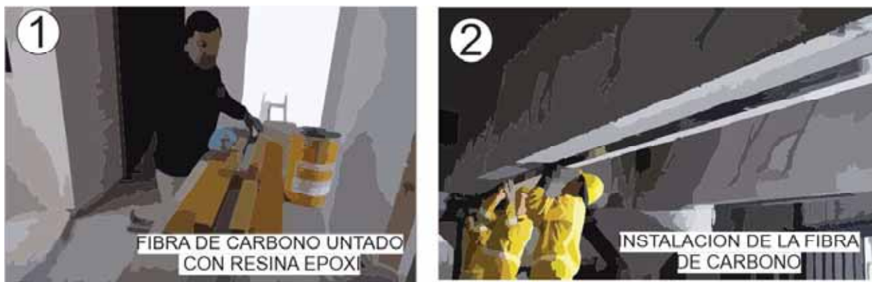
Figura 73: Instalación de la fibra de carbono Fuente: Fotografía Propia
