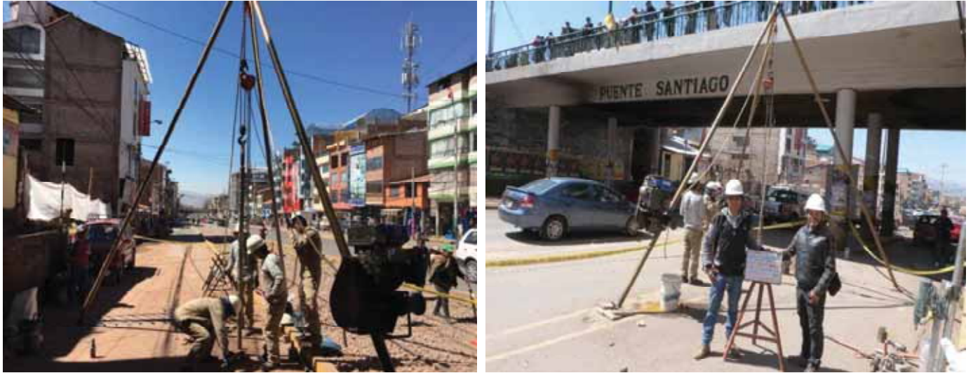
Figura 44: Punto 01 (carril de subida) - Punto 02 (carril de bajada) Fuente: Fotografía propia
