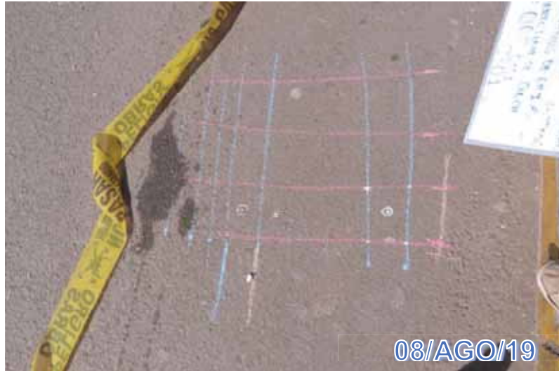
Figura 38: Ubicación de aceros de longitudinales y transversales Fuente: Fotografía Propia
