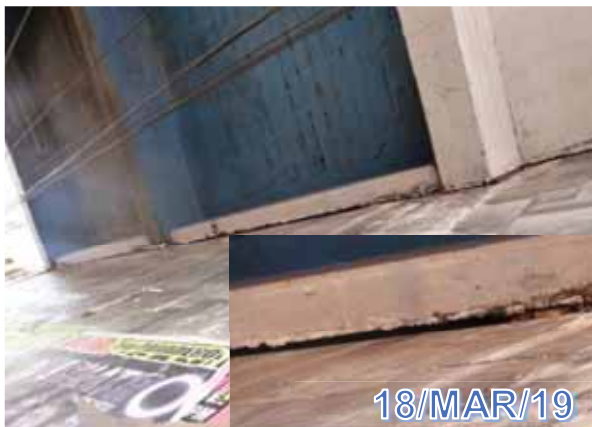
Figura 16: a) Eflorescencia del concreto en la V.S. de ambos carriles
