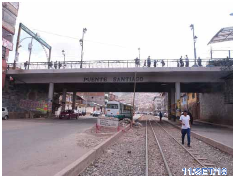
Figura 3: Estructura actual del Puente Santiago. Fuente: Fotografía Propia
