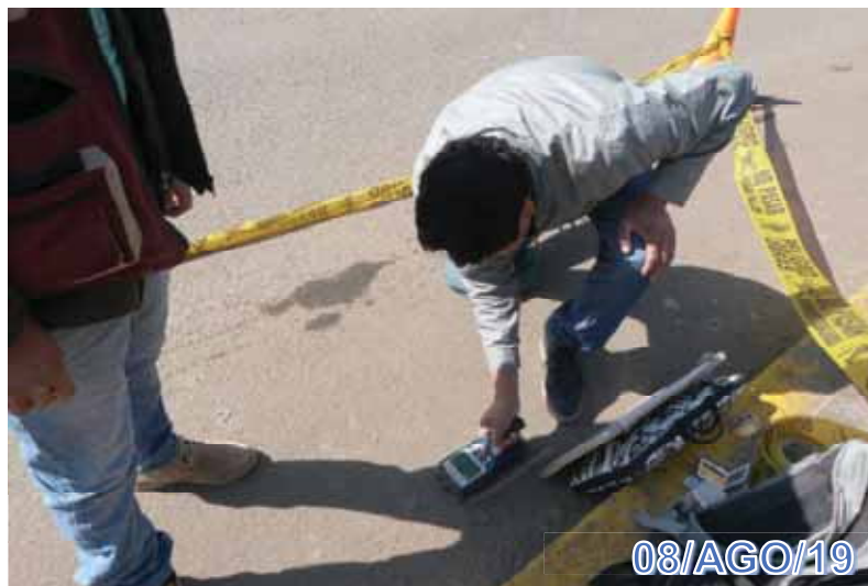
Figura 37: Detección de acero longitudinal con Pacómetro
