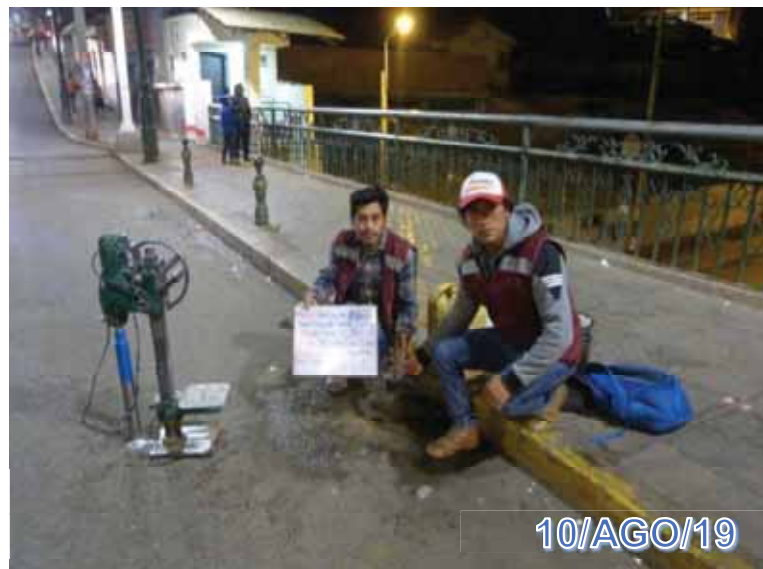
Figura 39: Extracción con diamantina en el L-01. Fuente: Fotografía Propia
