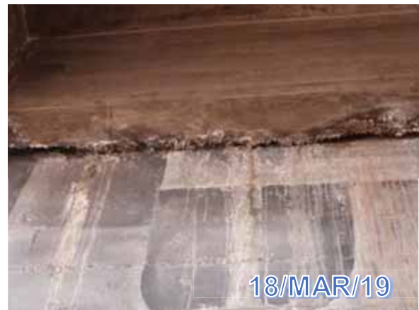
Figura 16: a) Eflorescencia del concreto en la V.S. de ambos carriles
