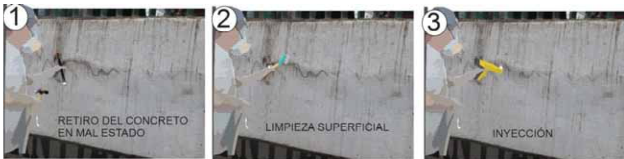
Figura 72: Inyección de grietas Fuente: Fotografía Propia
