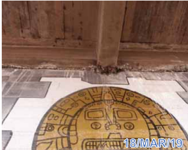
Figura 13: a) Eflorescencia y Acero expuesto en la V.P.C en ambos carriles
