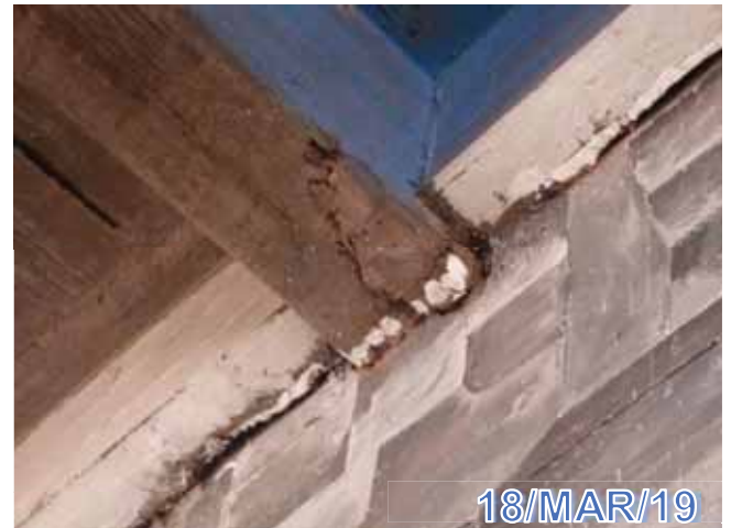
Figura 14: Desprendimiento de concreto en la V.P.C (carril de subida)
