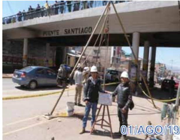
Figura 27: Toma de datos del Punto-02 Fuente: Fotografía Propia
