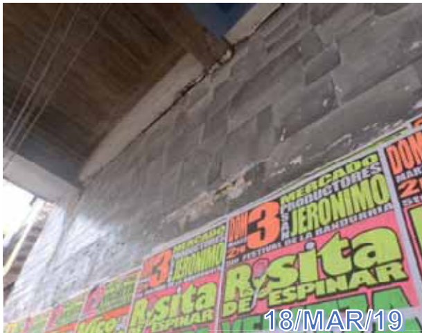
Figura 14: Desprendimiento de concreto en la V.P.C (carril de subida)
