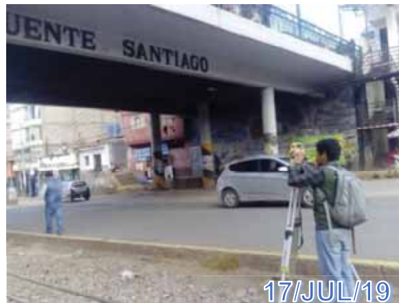
Figura 24: Levantamiento topográfico del puente Fuente: Fotografía Propia
