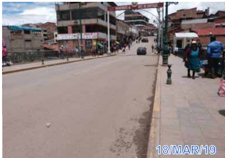
Figura 10: Parte superior de la losa.
