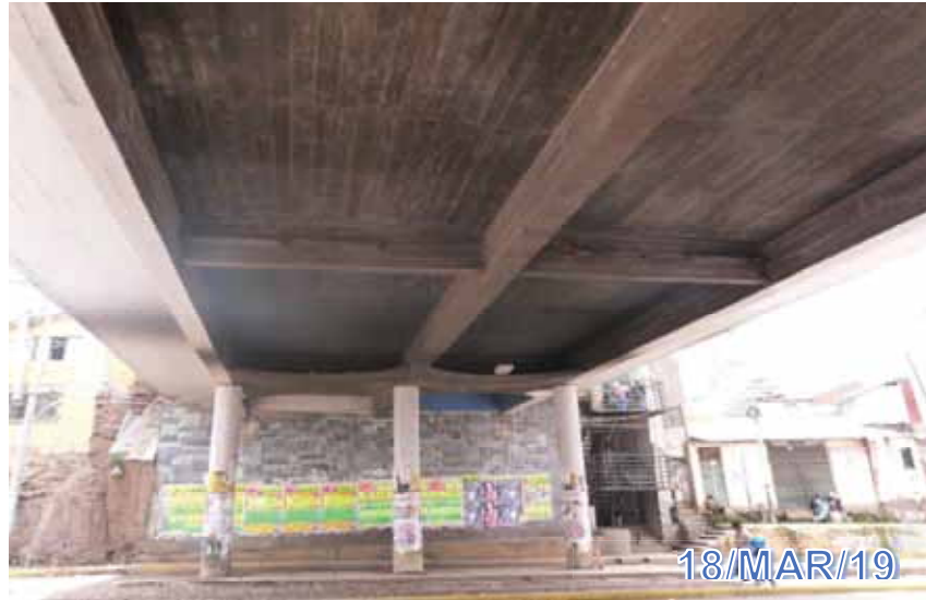
Figura 11: Parte inferior de la losa.
