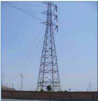
Torre N° 1 S.E. Paramonga Nueva
