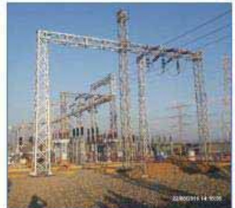
Excavaciones en S.E. Guadalupe
