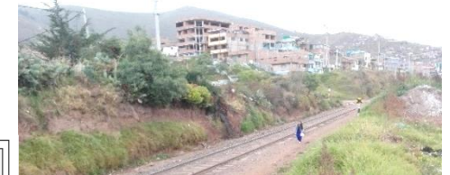
Imagen 73: vía férrea FUENTE: elaboración propia
