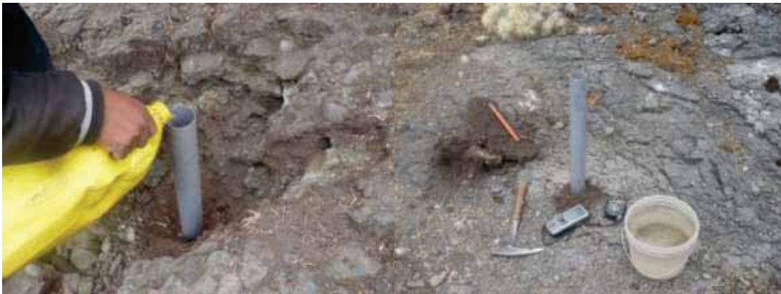
Fotografía 31. Pruebas de permeabilidad en roca.
