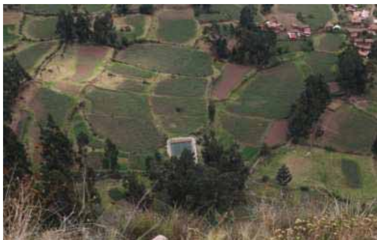
Fotografía 25. Reservorio ubicado en la parte baja.
