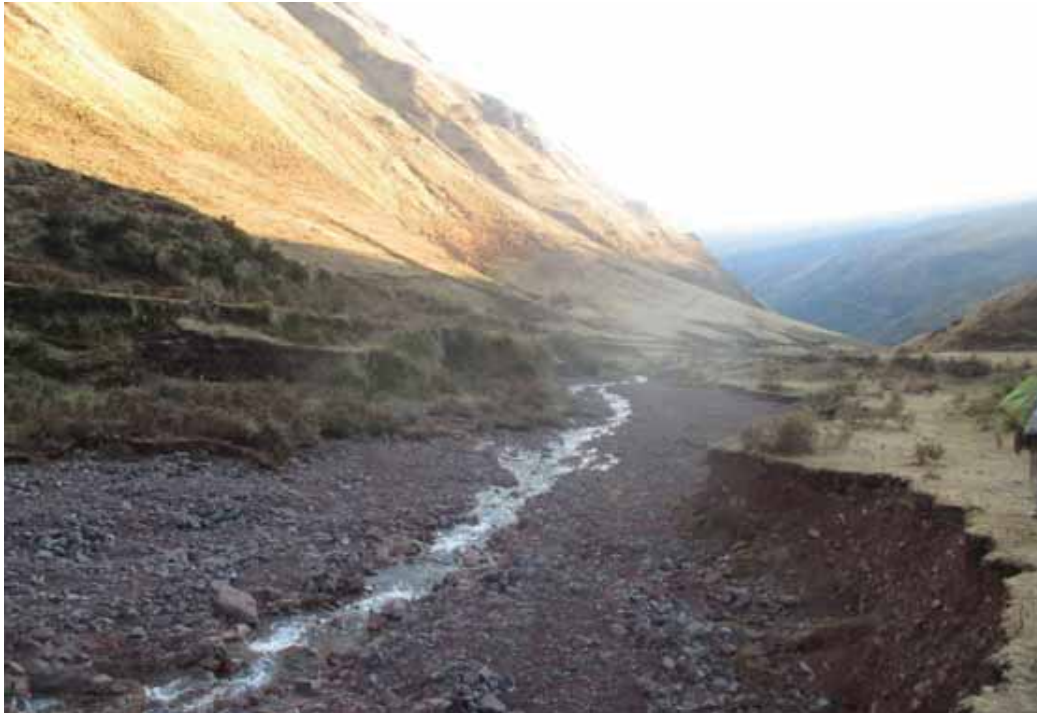
Fotografía 23: Obsérvese el arrasamiento de la quebrada Hatum Qelwaq'ocha, debido a la intensificación de las lluvias.
