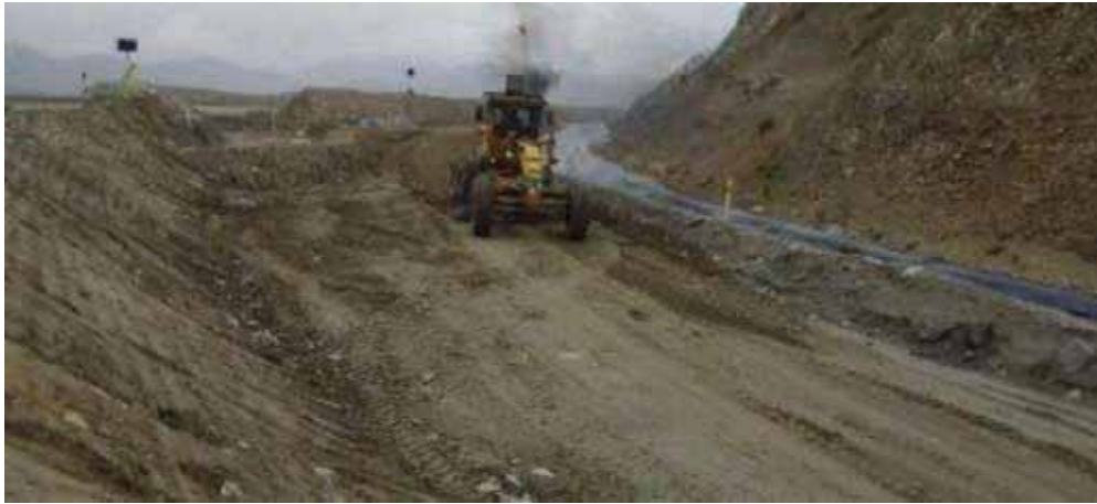
Figura n° 21: Mantenimiento de vía con equipo auxiliar.
