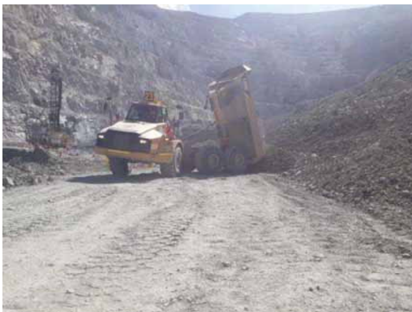
Figura n° 16: Camión articulado CAT 740B, descarga de material grava
