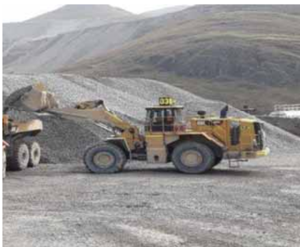
Figura n° 10: Cargador sobre ruedas 992K, para carguío de material
