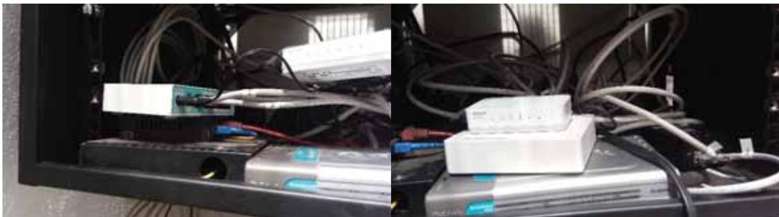
Figura 4.14 Instalación del servidor VPN MIKROTIK RB750.
