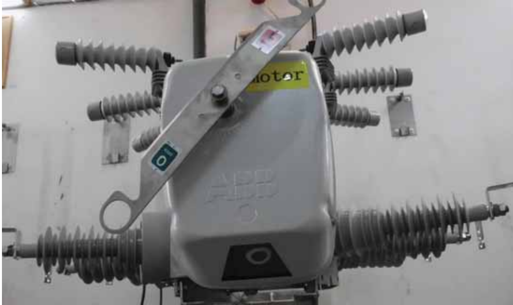
Figura 2: Seccionado bajo carga.
