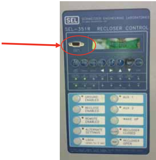
Figura 35: Vista frontal del módulo del panel de control y su entrada serial
