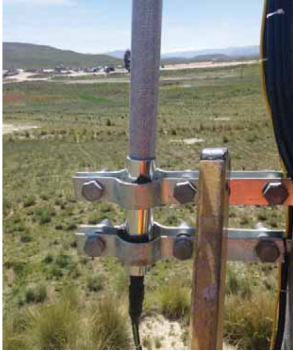
Figura 34: Sujeción de la antena
