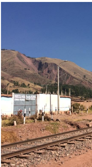
Imagen 41 Energía Eléctrica FUENTE Propia
