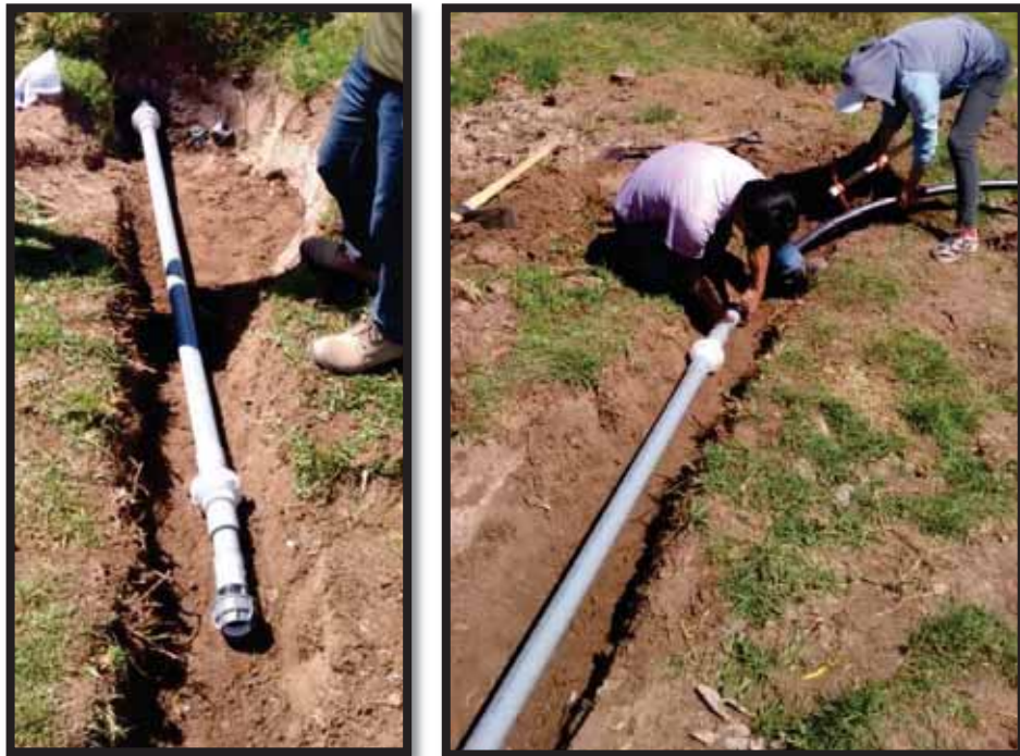
Fotografía 8. Vista de la línea de suministro de agua, uniéndose a una manguera de polietileno de 2”.
