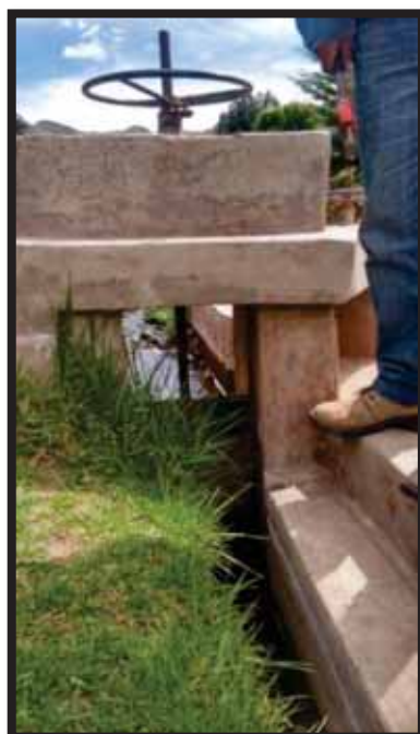
Fotografía 1. Bocatoma sector "Chanchería"
