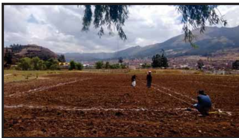
Fotografía 6. Marcación para la ubicación del sistema de riego.
