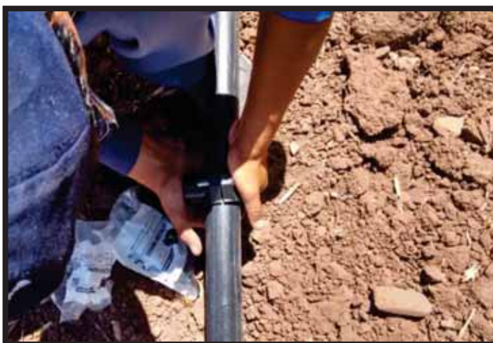
Fotografía 13. Colocación de las válvulas en la línea de conducción principal.
