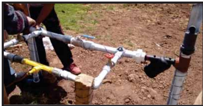
Fotografía 9. Instalación del cabezal de riego.
