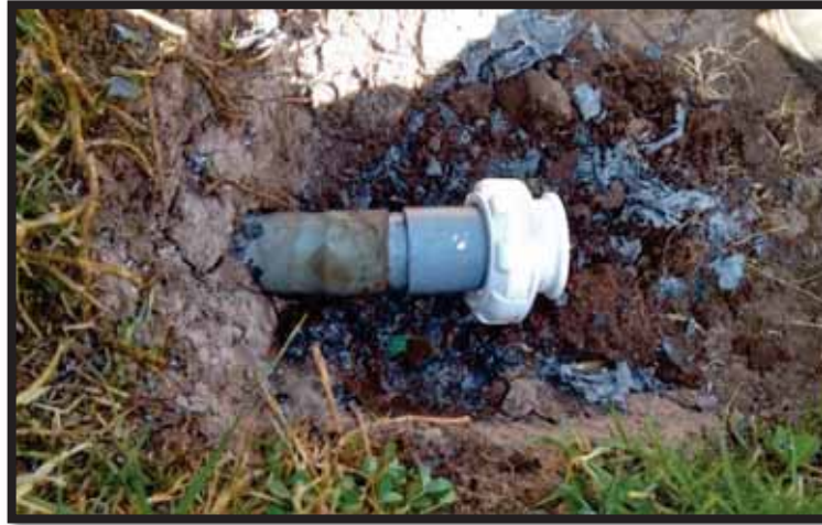
Fotografía 8. Vista de la línea de suministro de agua, uniéndose a una manguera de polietileno de 2”.
