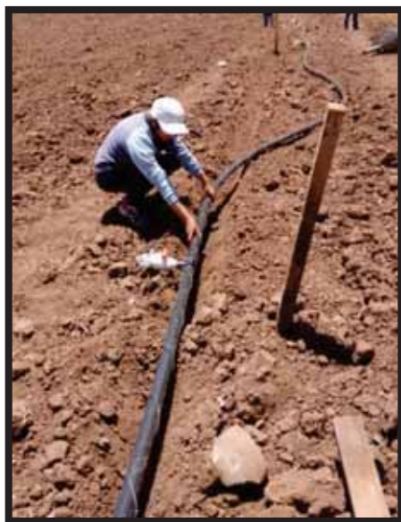
Fotografía 11. Colocación de la línea de conducción principal de riego.
