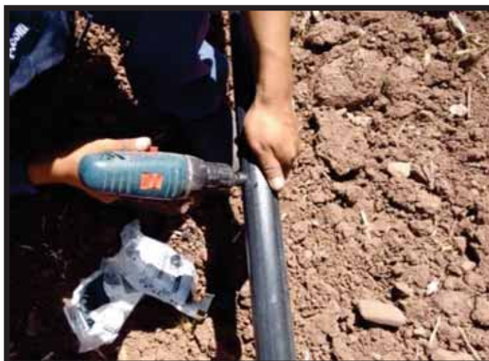
Fotografía 13. Colocación de las válvulas en la línea de conducción principal.
