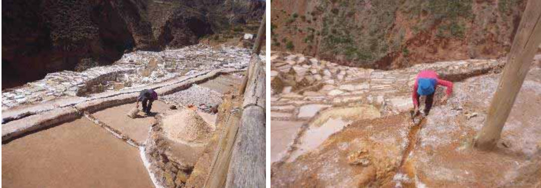
Mantenimiento de Pozas y Canales
