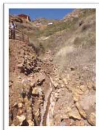
Foto N°03: Manante Orco pujio
