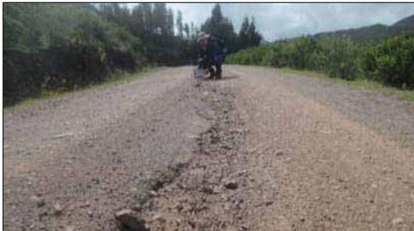
Foto N° 17: Grietas originadas por mal uso de las cunetas de hasta 5cm de profundidad (Fuente: propia)
