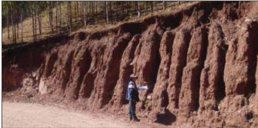
Foto N° 16: Erosión en surco originada por lluvias torrenciales KM 3+620 al 3+660 (Fuente: propia)
