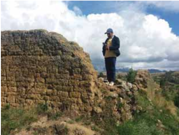
Foto 9: Mapeo en muro de mampostería que separa de Lauramarca con Ccolcca
