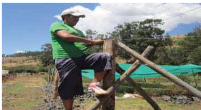
**Fotografía N° 03:** Templado del alambre galvanizado.
