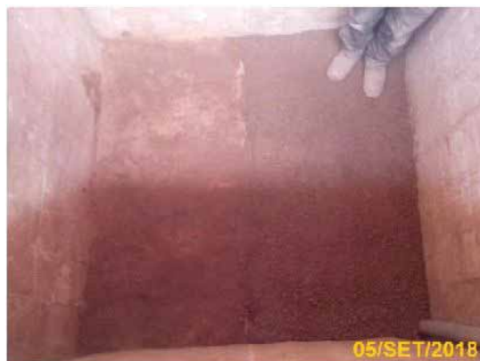
Imagen 4.4. Capas de arcilla y grava dentro del pozo previo al compactado Fuente: Fotografía propia.
