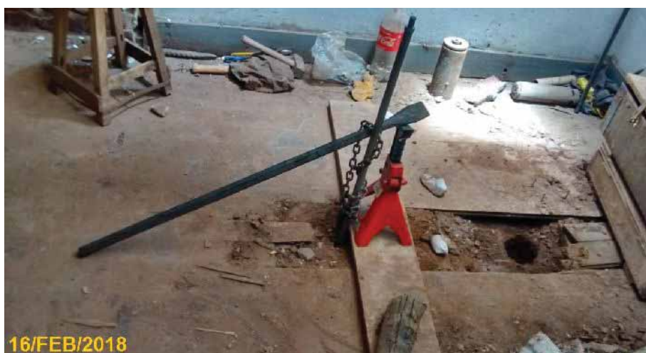
Imagen H.18: Extracción de tubos PDC. Fuente: Fotografía propias.
