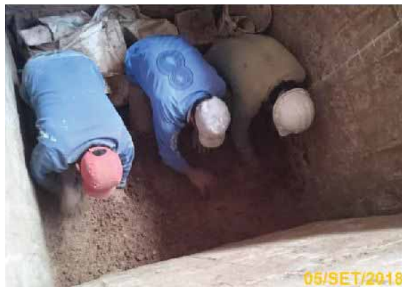
Imagen 4.3. Mezclado manual de la arcilla y el agua. Se realizó mediante el regado de agua con delgadas subcapas de arcilla para lograr la mayor uniformidad posible de humedad Fuente: Fotografía propia.
