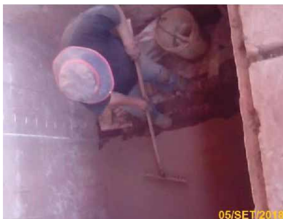
Imagen 4.8. Esparcimiento del suelo en el área de diseño. Pozo de prueba del Laboratorio de Mecánica de Suelos y Materiales-UNSAAC.
