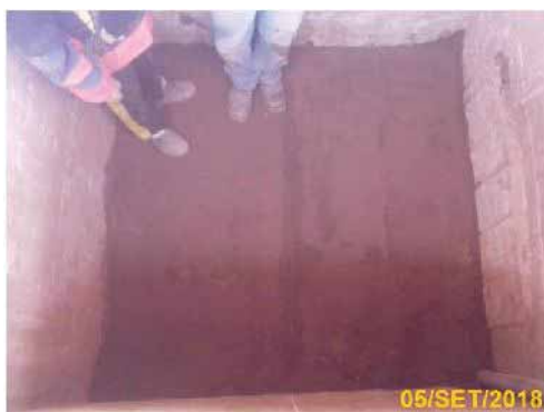
Imagen 4.5. Capas de limo y arena en el pozo previos al compactado Fuente: Fotografía propia.
