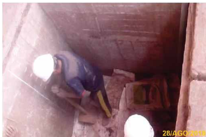
Imagen 4.7. Compactación con el uso de Apisonador manual de concreto. Pozo de prueba del Laboratorio de Mecánica de Suelos y Materiales-UNSAAC.
