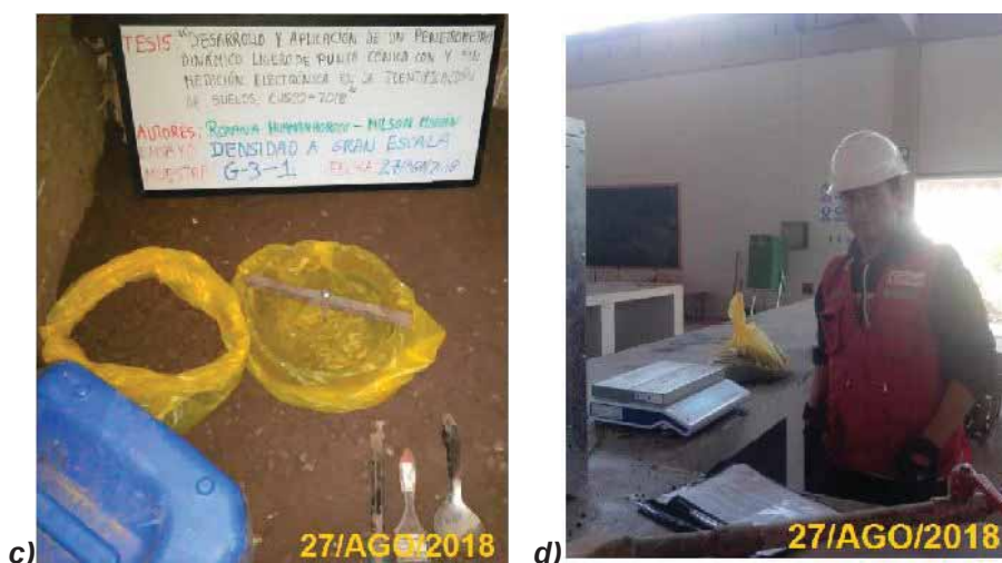
Imagen 4.1. Ensayo "Test pit" para gravas. En las fotografías se muestra los procedimientos de la prueba de densidad a gran escala. a) Excavación y limpieza del hoyo. b) Hoyo con membrana y agua. c) Medición del volumen del hoyo. d) Pesaje del material extraído.
