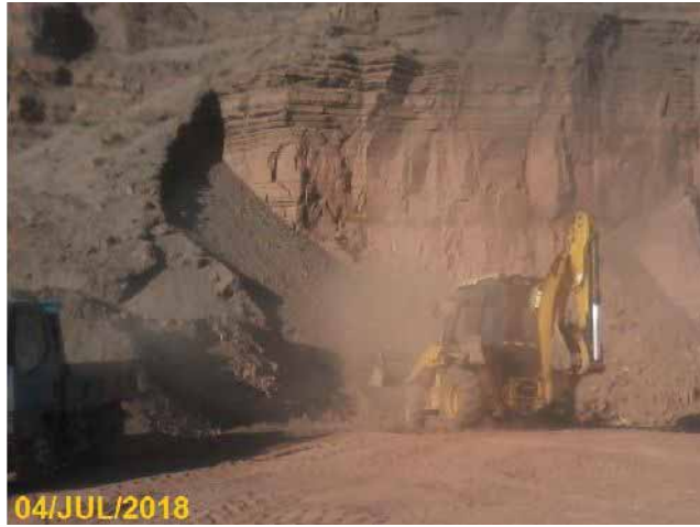
Imagen H.7: Extracción y traslado de muestras de arena y limo a partir de estratos naturales en San Jerónimo, Cusco.
