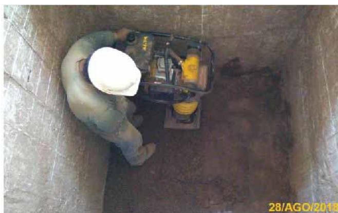
Imagen 4.6. Compactación con el uso de Apisonador mecánico
